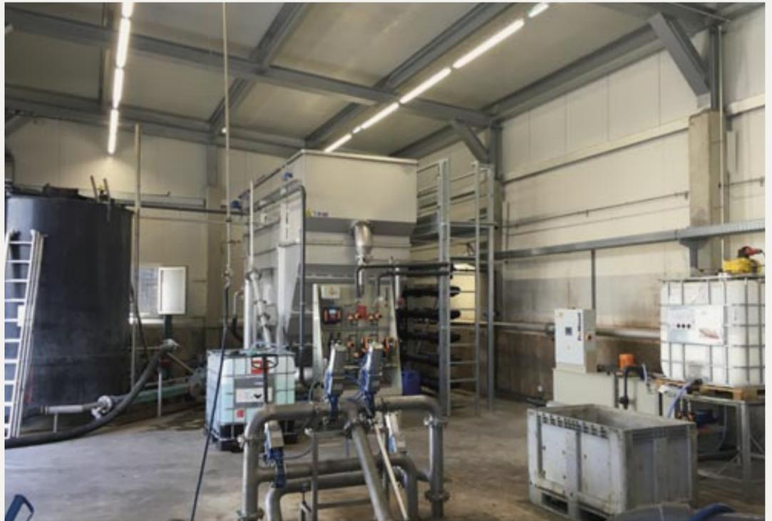
HUBER Druckentspannungsflotation HDF10 mit chemischer Stufe.
