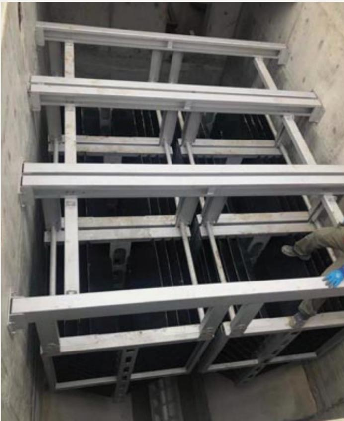
Montage der Lamellenpakete im Betonbehälter.
