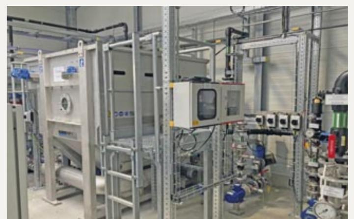
Übersicht der HUBER Druckentspannungsflotation HDF S2.
