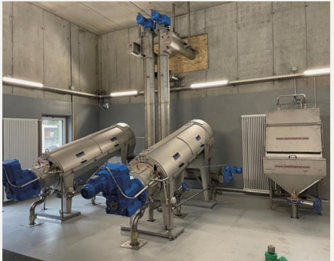
2 HUBER Schneckenpressen Q-PRESS® mit Senkrechtförderschnecken für den entwässerten Klärschlamm.
