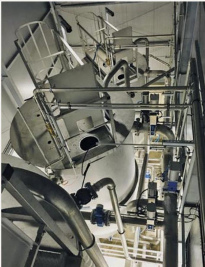
HUBER CONTIFLOW® Technologie: Herzstück der mehrstufigen Adsorptionsanlage.
