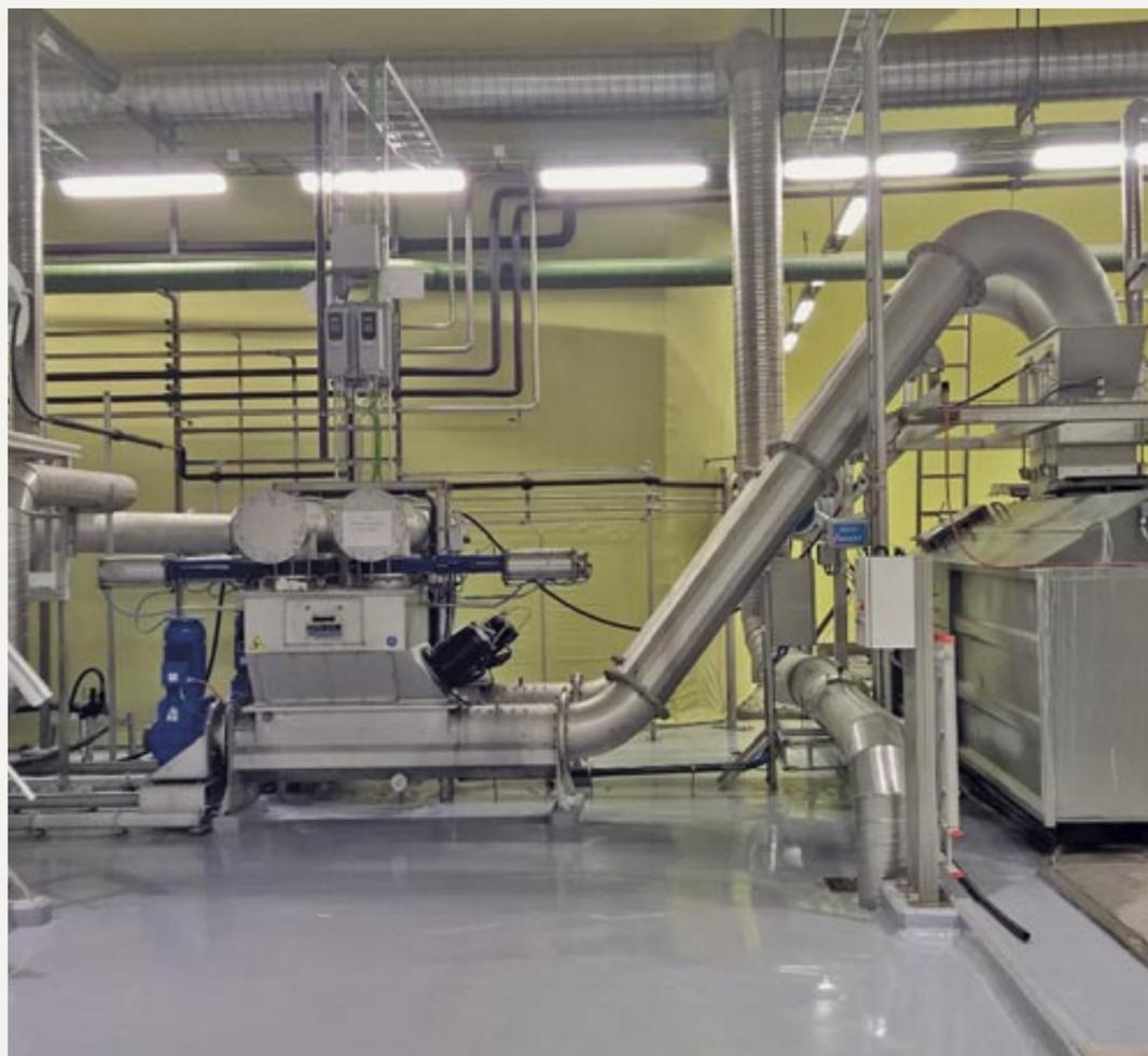
Abbildung 5: Musteranlage: redundante Beschickung via HUBER Schwemmrinne zweier HUBER Waschpressen WAP SL mit bester Waschleistung, voll geschlossene Containerbeschickung mit redundanter Verteilung.
