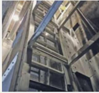
Abbildung 2: HUBER Bandrechen CenterMax® Star mit 2 mm Lochblech als freitragende Rahmenkonstruktion: 8,6 m lang mit einer Durchsatzleistung von 2.160 m³/h (600 l/s).
