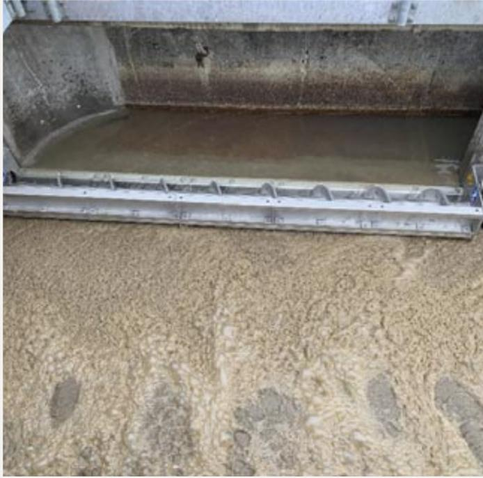
HUBER Siebanlage ROTAMAT® RoK1 300/2 3125 0° im Werkstoff V4A.
