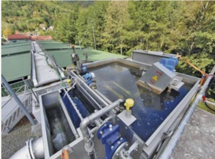
Abbildung 1: Vorführanlage HUBER Scheibenfilter RotaFilt®: Einsatz im Anschluss an die Nachklärung. (Foto Kläranlagenpersonal)
