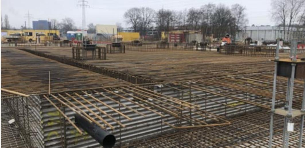
Stützeinbauteile in Bewehrung eingebunden.
