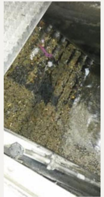
Fettdurchsetzter Rechengutteppich im Zulauf der bestehenden Stufenrechen, Kläranlage Osnabrück-Eversburg.
