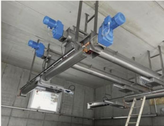
HUBER Verteilerschnecken für eine redundante Beschickung der Container mit entwässertem Klärschlamm.
