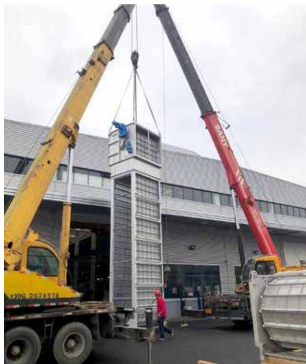
Auslieferung und Einheben eines HUBER Bandrechens CenterMax®
