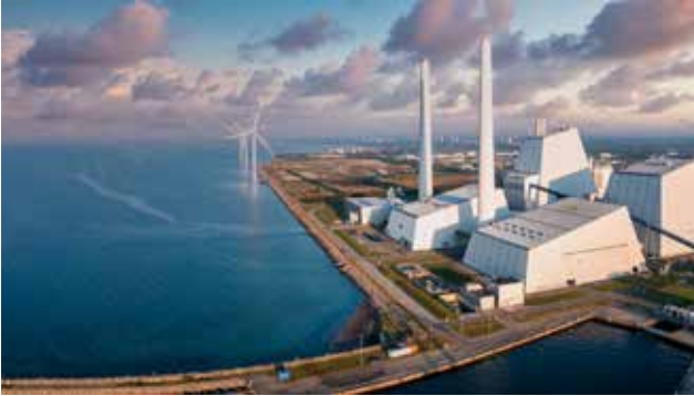
Nutzung als Kühlwasser in thermischen Kraftwerken.
