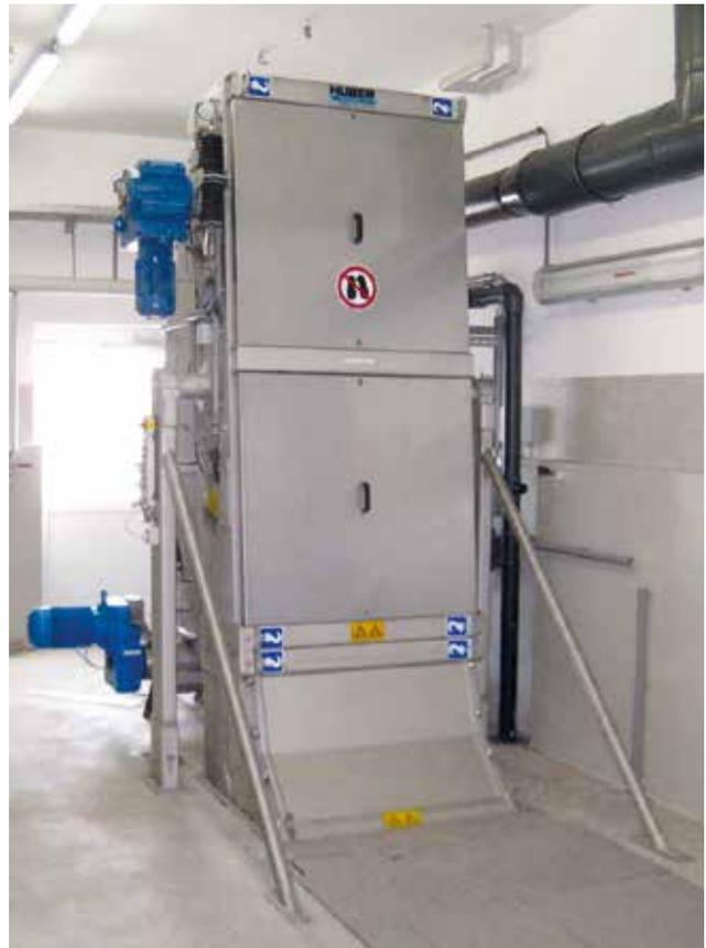
Der HUBER Harken-Umlaufrechen RakeMax® HF ist von außen fast nicht von der bewährten Basismaschine RakeMax® zu unterscheiden.
