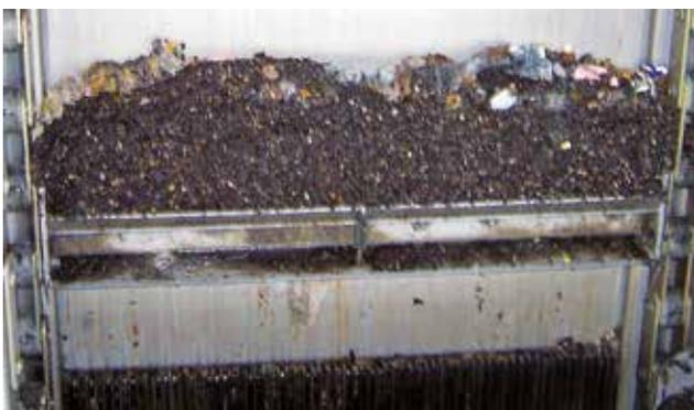
*Bei kleinen Spaltweiten – hier 6 mm – werden die Rechenstäbe aus einem strömungsgünstigen Rechenstabprofil hergestellt. Hierdurch wird der Druckverlust gegenüber Flach- oder Trapezprofilen erheblich reduziert. Außerdem zeigt sich bei dieser Profilform, dass sich Feststoffe in den Spalten nicht verkleben können. Der Rechen beweist damit seine Unempfindlichkeit gegenüber Sand und Splitt.*
