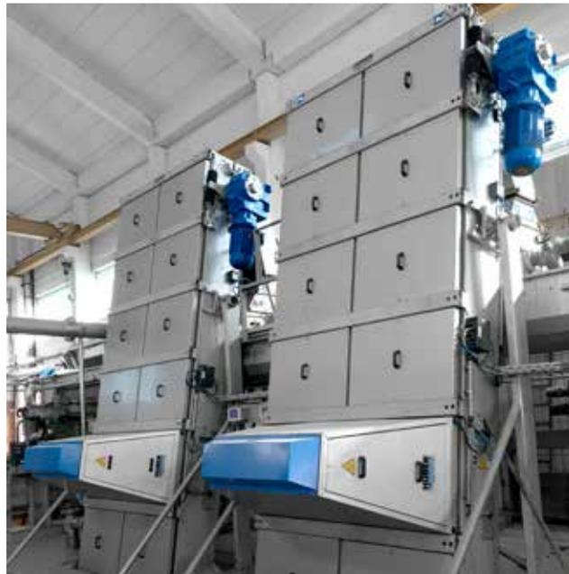
Zwei HUBER Harken-Umlaufrechen RakeMax® ausgestattet mit der HUBER Störstofferkennung Safety Vision. Durch das Erkennen von kritischem Rechengut verhindert Safety Vision Schäden am Rechen und den nachgeschalteten Maschinen.
