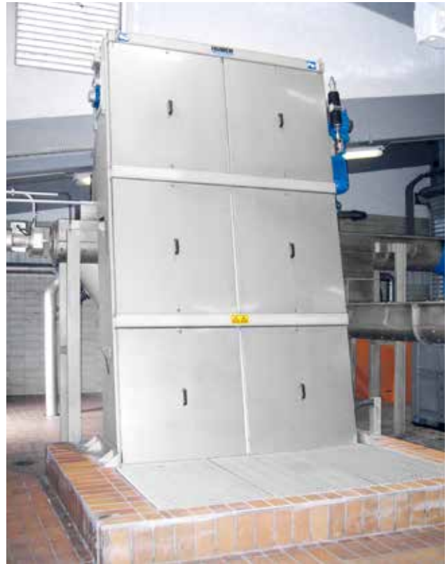
Der HUBER Harken-Umlaufrechen RakeMax® HF ist von außen nicht von der bewährten Basismaschine RakeMax® zu unterscheiden.
