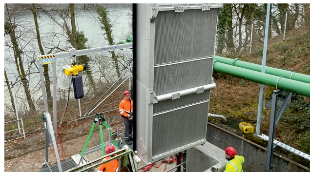
Einbau eines HUBER Harken-Umlaufrechens RakeMax® V bei einer Anlagenmodernisierung.
