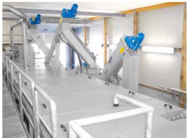
Kompaktanlage mit integriertem Sandwäscher.
