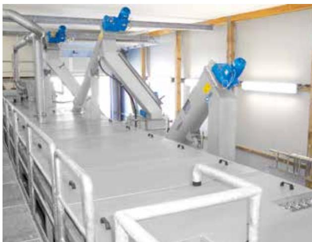
*Sauberer Rechengut- und Sandfanggutaustrag bei der HUBER Kompaktanlage ROTAMAT® Ro5.*
