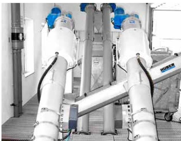
*Unterirdische, redundante Ausführung der HUBER Kompaktanlage ROTAMAT® Ro5.*
