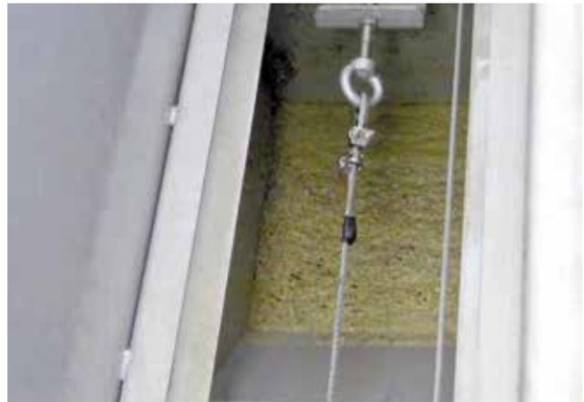
Das Fettpaddel arbeitet nach dem Prinzip eines Längsräumers, der das aufschwimmende Fett in die Pumpvorlage schiebt.
