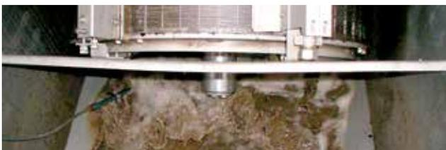
Bewährte Abwasserfeinstsiebung mittels HUBER Siebanlage ROTAMAT® Ro2.
