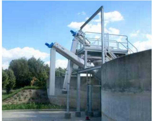
Kompaktanlage ausgeführt mit einer ROTAMAT® Ro9 Vorsiebung.
