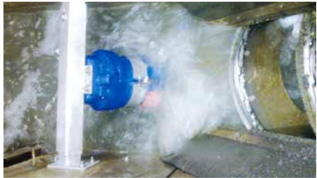
*Bei der externen Rechengutauswaschung (ERGA) werden, die organischen Bestandteile über eine vorgeschaltete Auswaschvorrichtung gelöst und ausgewaschen.*
