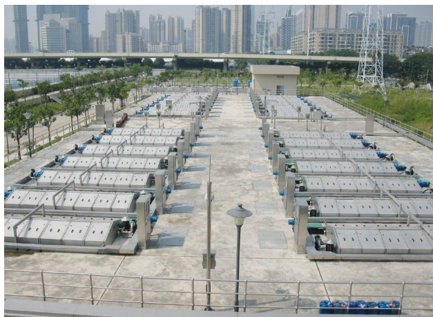
28 x Diskový filtr RoDisc®, každý s 24 disky, čistí cca 8,5 m 3 odpadní vody za sekundu.
