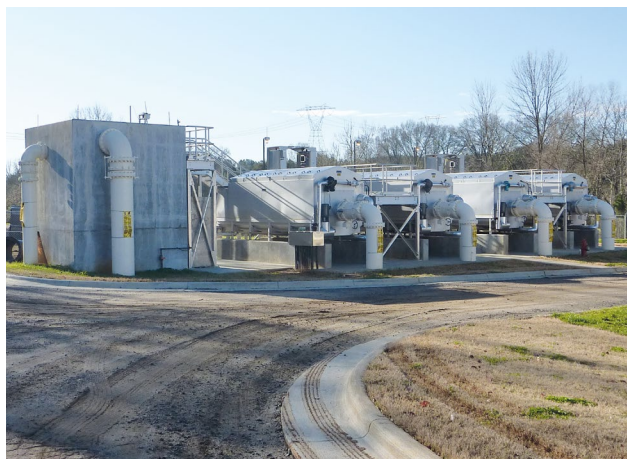
4 x Diskový filtr HUBER RoDisc® s 18 disky v nádobě z nerezové oceli.
