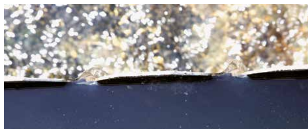
Belebtschlammflocken können im Nachklärbecken oft nicht ausreichend zurückgehalten werden.
