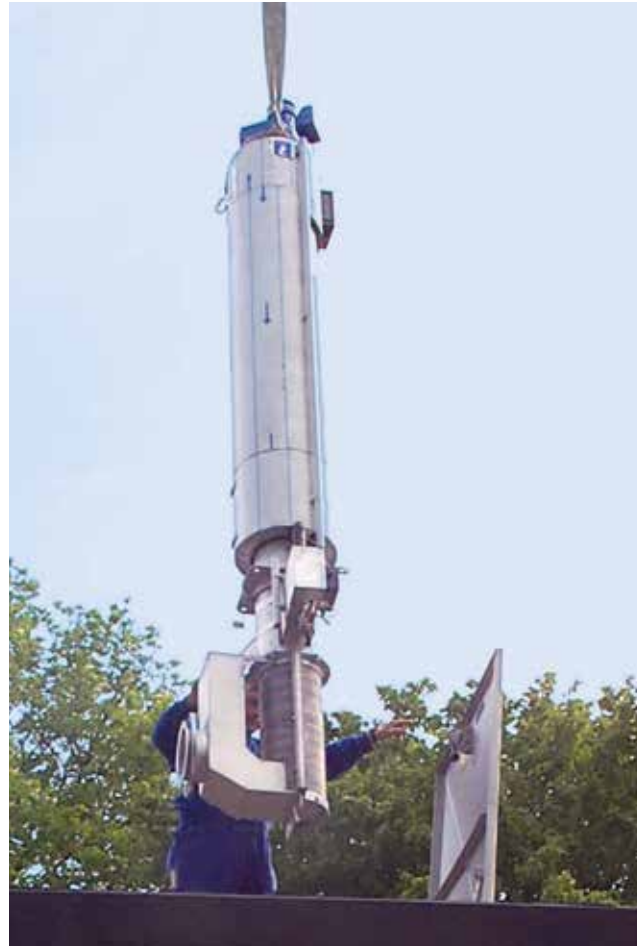
„Einheben der HUBER Schachtsiebanlage ROTAMAT® RoK4 in ein Pumpwerk.“
