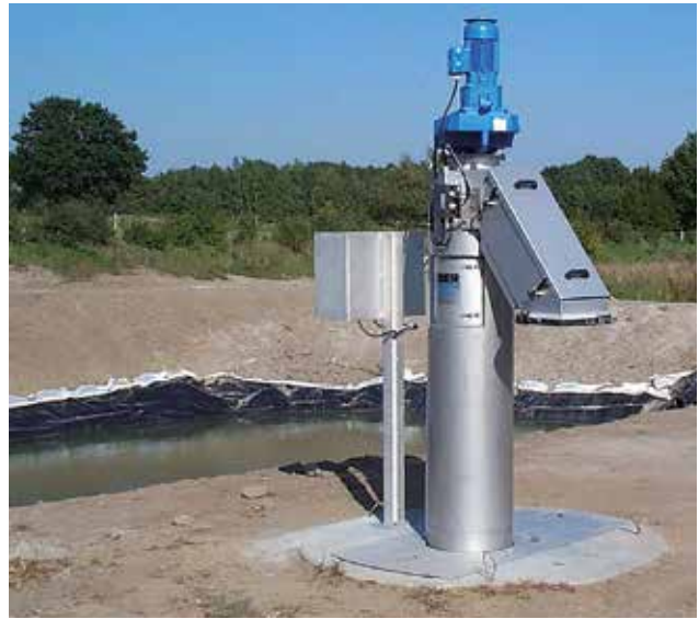
„Einsatz im Zulauf vor einer Teichkläranlage.“
