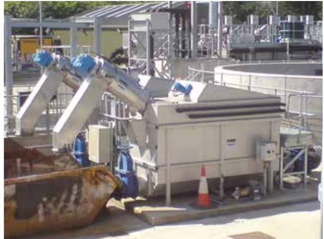
In Behältern installierte Feinstsiebe HUBER Membrane Screen ROTAMAT® RoMem.
