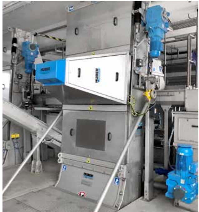
Abbildung 1: HUBER Safety Vision an einem HUBER Harken-Umlaufrechen RakeMax®.
