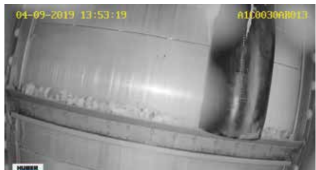
Abbildung 2: Exemplarisches Bild zur Benachrichtigung des Betreibers – Rohrdichtkissen auf dem Harkenbalken eines HUBER Harken-Umlaufrechens RakeMax®.
