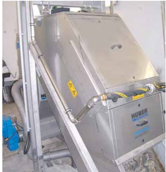
HUBER Stufenrechen STEP SCREEN® SSF in geruchsgekapselter Ausführung.
