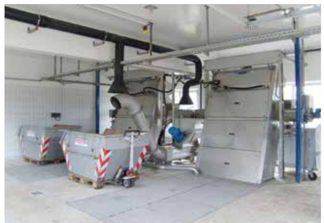
Zwei HUBER Stufenrechen STEP SCREEN® SSV, Länge 4300, Breite 1676, Spaltweite 6 mm, in Kombination mit der HUBER Rechengutwaschpresse WAP® der Baureihe SL für eine intensive Rechengutauswaschung in komplett geruchsgekapselter Ausführung.
