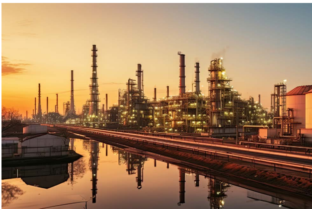
Prozess- und Kühlwasser für Chemieanlagen und thermische Kraftwerke, z. B. Deutschland: 1 x TrashLift 9425 x 2000 mit 16 mm Spaltweite und 90° Maschinenaufstellung.
