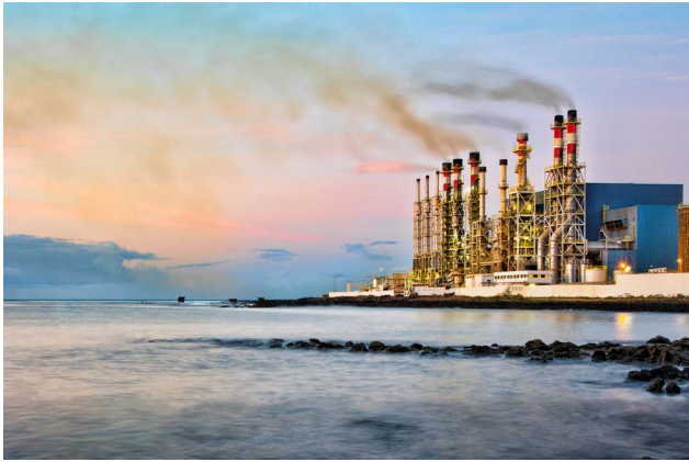
Rohwasser für Anlagen zur Meerwasserentsalzung.
