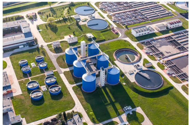
Entfernung von Grobstoffen aus dem Zulauf von Großkläranlagen, z. B. China: 3 x TrashLift 16140 x 1700 mit 20 mm Spaltweite und 75° Maschinenaufstellung.
