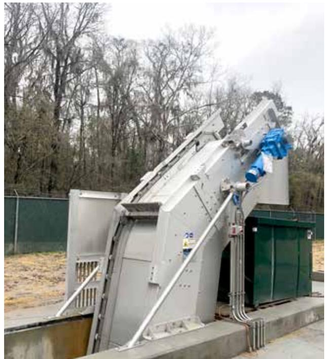
Recheninstallation im Zulauf einer Pumpstation mit Abwurf direkt in einen Container.
