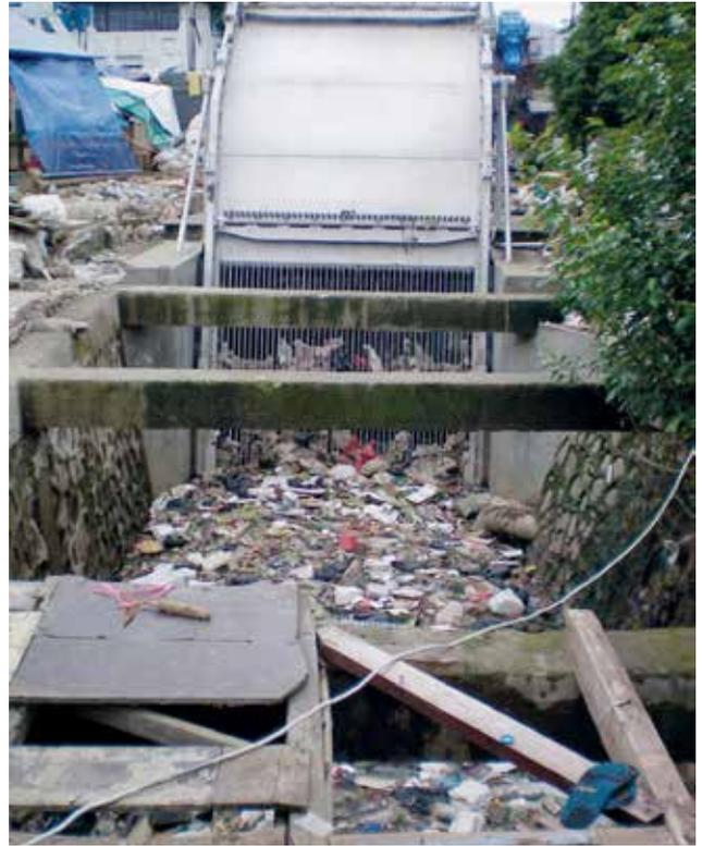
In Betrieb befindlicher HUBER Grobrechen TrashMax®.
