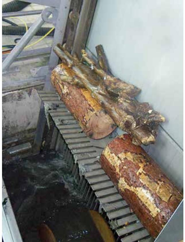
*Die Reinigung des Rechenrostes erfolgt durch äußerst robuste Reinigungsharken mit einer großen Aufnahmekapazität deren Anzahl an die jeweilige Austragskapazität angepasst werden kann. Hierdurch wird selbst extrem sperriges Rechen- und Treibgut zuverlässig von den Rechenharken aufgenommen und aus dem Gerinne zum Rechengutabwurf transportiert.*
