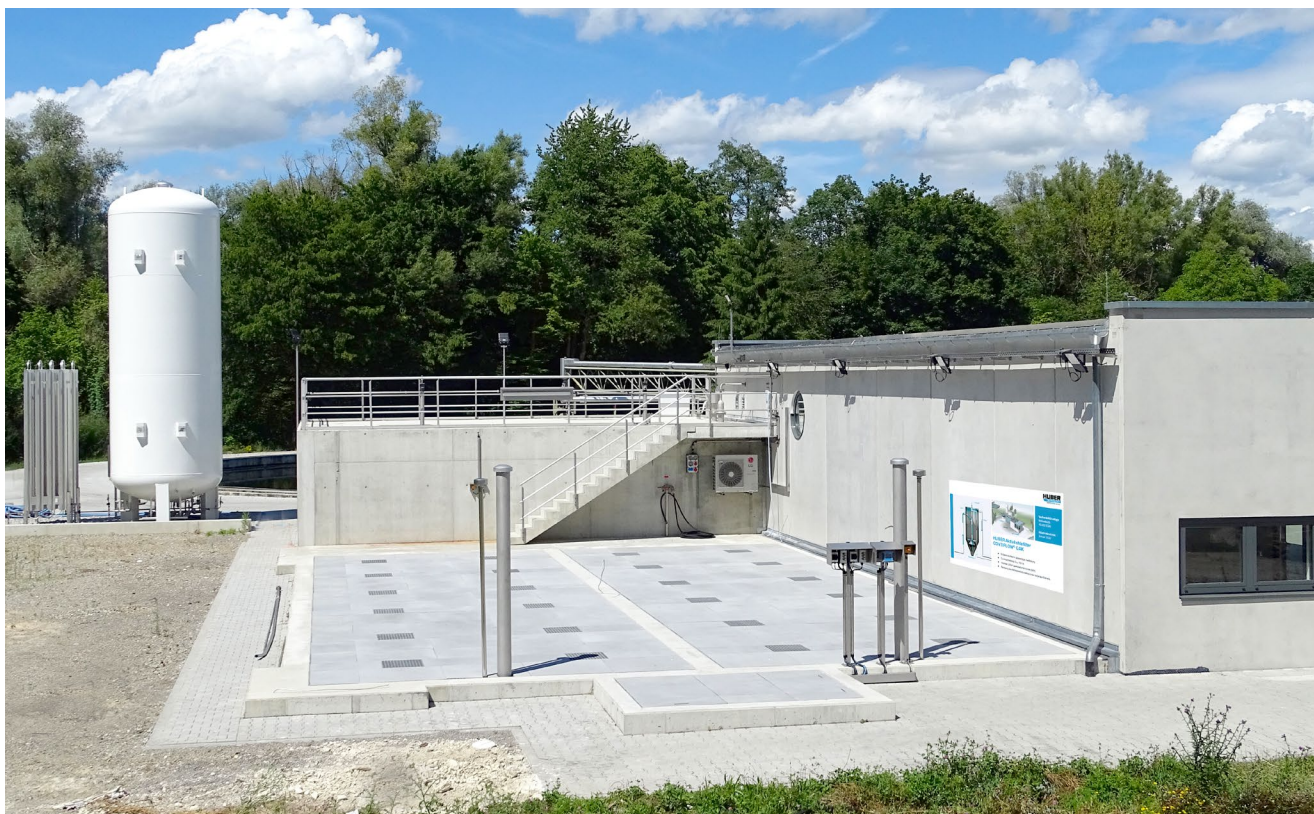
HUBER Filtr s aktivním uhlím CONTIFLOW® GAK s předřazenou ozonizací.
