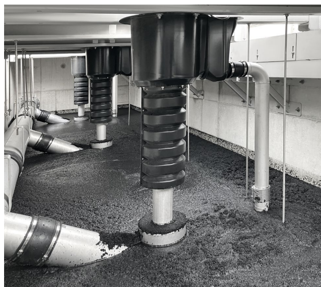
Filtr s aktivním uhlím HUBER CONTIFLOW® GAK (tankové provedení).
