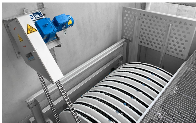
Filtrační komora s instalovanou jednotkou RotaFilt®.
