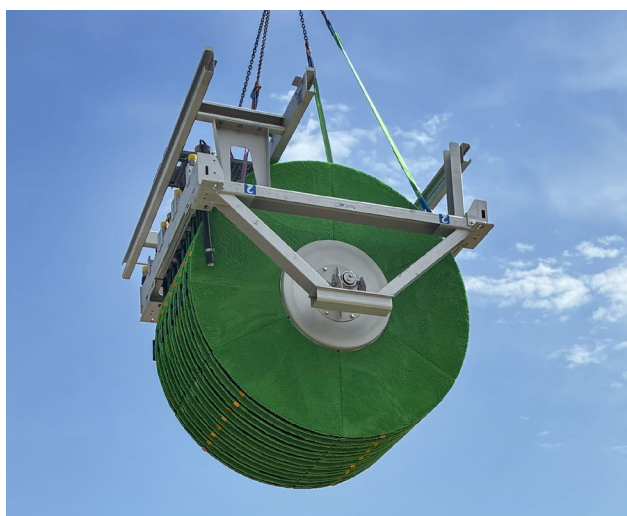
Filtr RotaFilt® se zvedne do filtrační nádoby.
