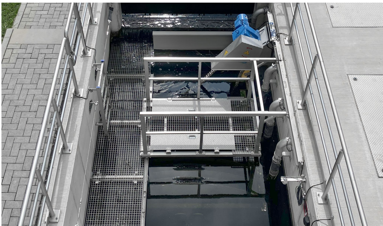
Filtr z vláknité tkaniny HUBER RotaFilt® v provozu.
