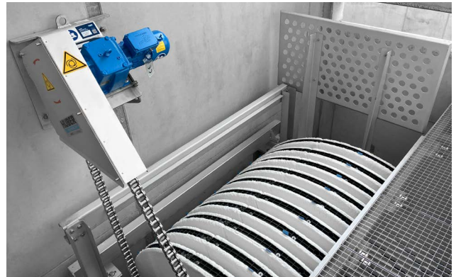
Filtrationskammer mit HUBER Tuchfilter RotaFilt®.
