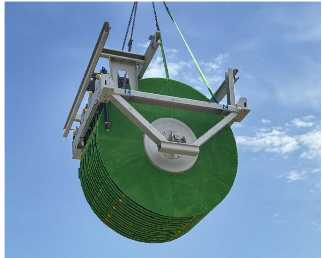
Einheben einer RotaFilt® in das Filterbecken.
