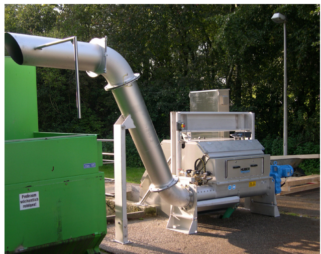
Zuverlässig Rechengut behandeln mit der HUBER Waschpresse WAP®.
