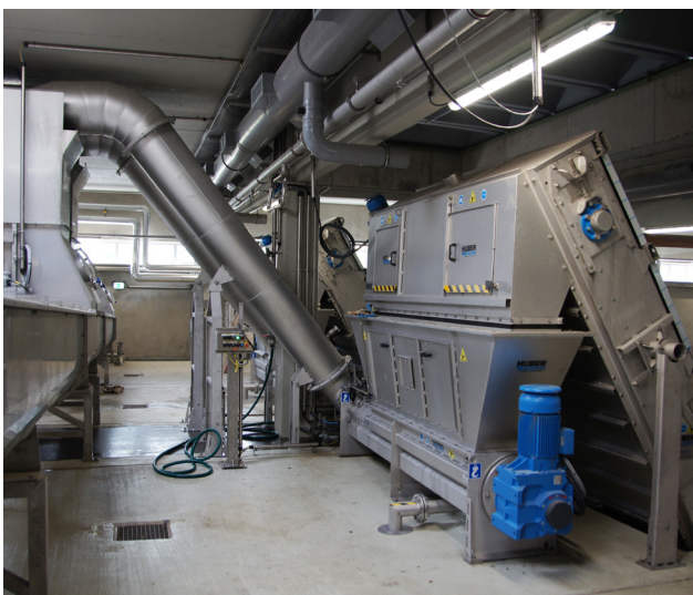
Typische Anwendung: Direkte Beschickung einer HUBER Waschpresse WAP® durch Rechen.
