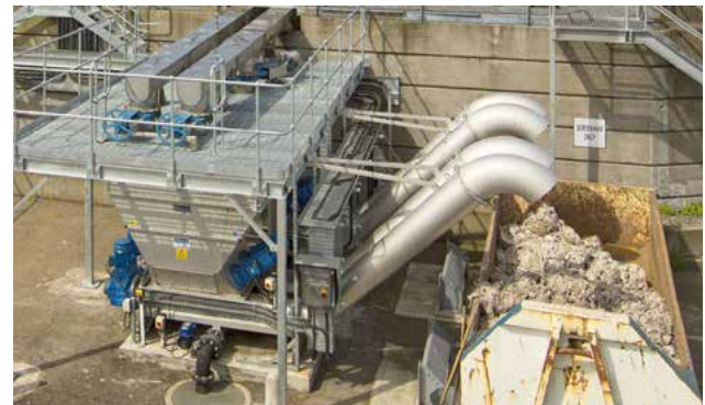
Gewaschenes und nahezu geruchsloses Siebgut aus einer HUBER Waschpresse WAP® SL, kompaktiert zu 50 % TR.
