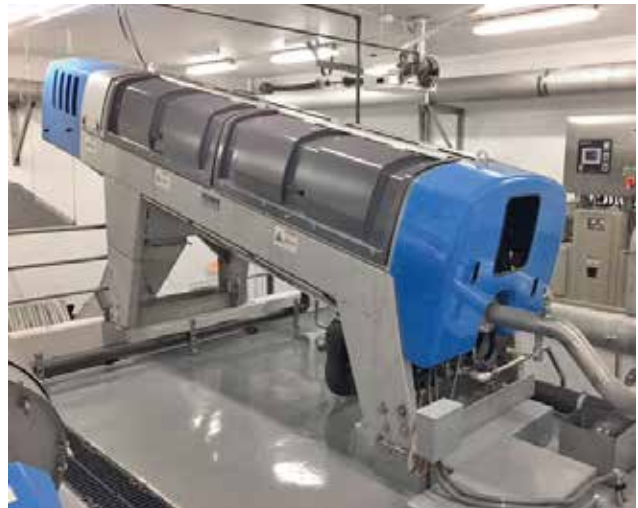
Q-Press® 620.2 zur Überschussschlammmentwässerung.
