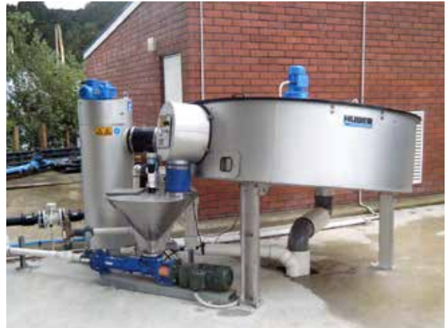
Außenaufstellung eines HUBER Scheibeneindickers S-DISC.
