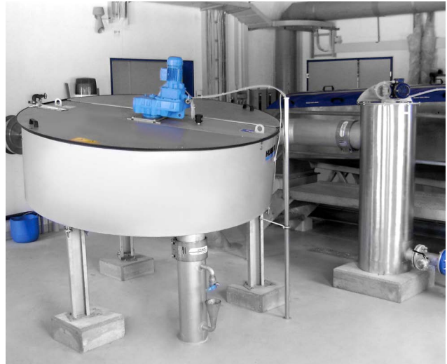
HUBER Scheibeneindicker S-DISC Baugröße 2 mit vorgeschaltetem Flockungsreaktor.
