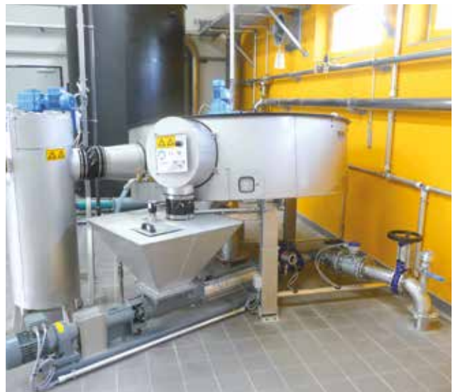
HUBER Scheibeneindicker S-DISC zur Eindickung von 35 m 3 /h.
