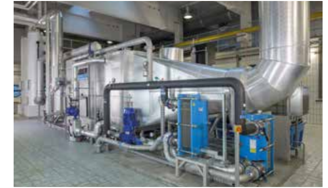
Kondensationsstufe mit Wärmeauskoppelung und vollautomatischer Wärmetauschreinigung.
