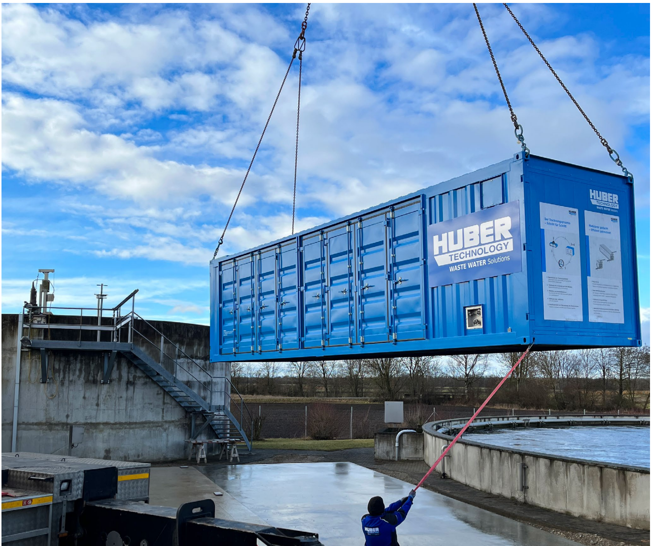
Einfache Trocknermontage durch Containerdesign.
