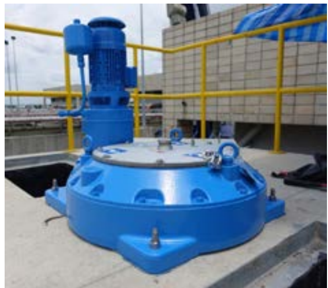
Robuster BULLGEAR-Antrieb für das Rührwerk mit Druckluftheber.
