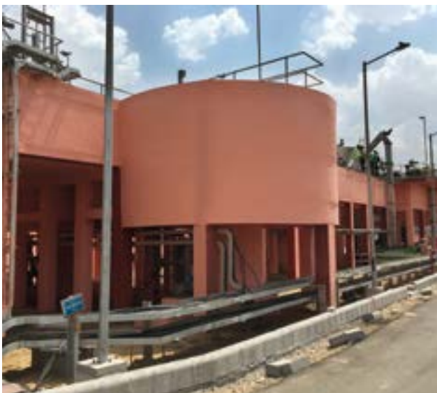
HUBER Rundsandfang VORMAX Installation mit HUBER Coanda Sandwaschanlage RoSF4.
