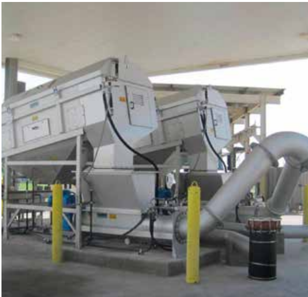
Auswaschen und Abtrennen aller Grobstoffe > 10 mm mit der HUBER Waschtrommel.
