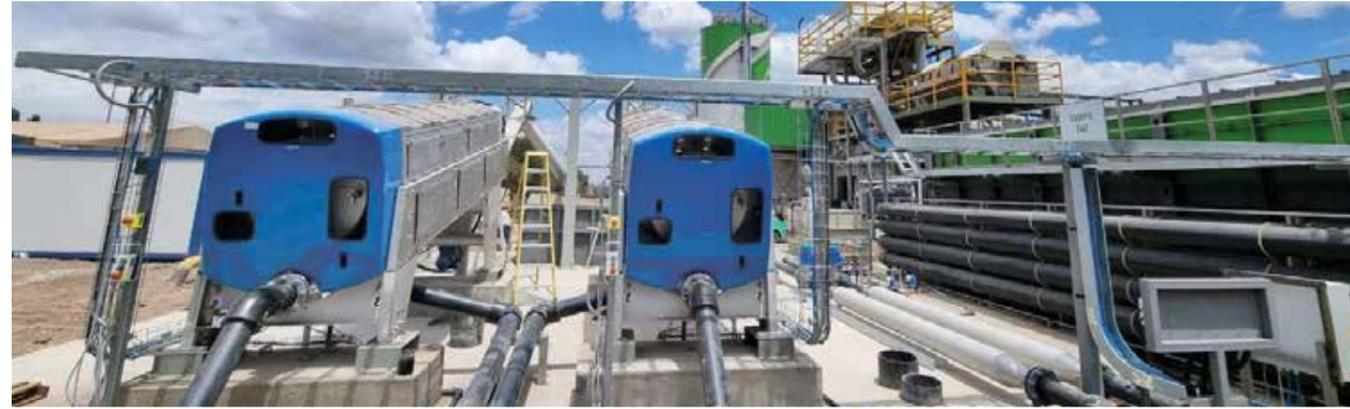
HUBER Schneckenpressen zur Schlammbehandlung – beste Entwässerungsleistung und höchste Volumenreduktion zur Senkung der Entsorgungskosten.
