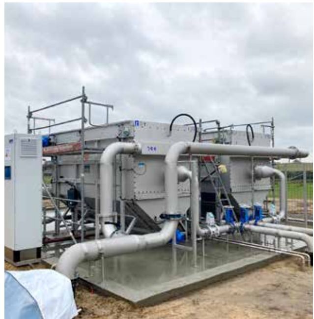
HUBER Abwasserwärmetauscher – Energierückgewinnung und Abwasserkühlung.
