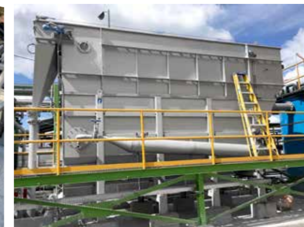
HUBER Druckentspannungsflotation zur physikalisch-chemischen Vorreinigung – optimale Reduktion von CSB, Fetten und Feststoffen – mehr als 500 Installationen weltweit.
