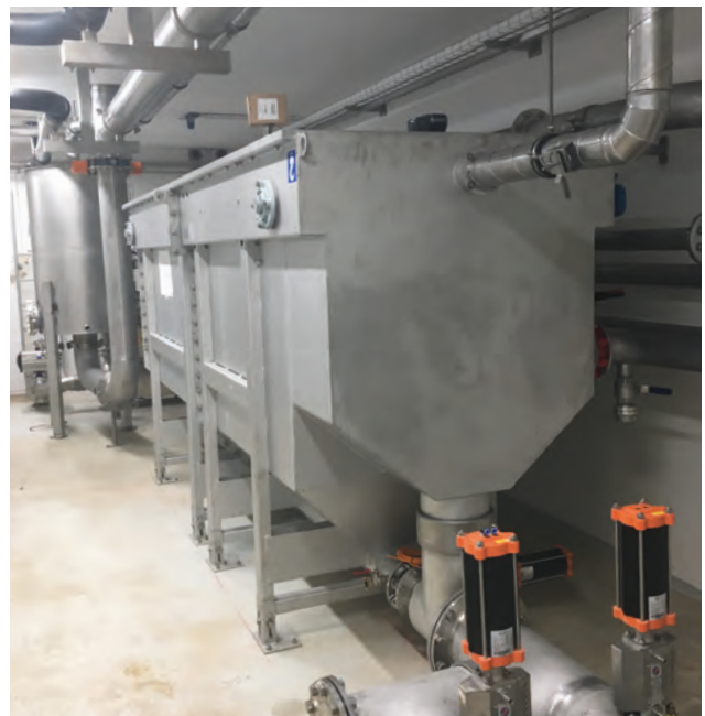
HUBER Abwasserwärmetauscher RoWin zur Wärmerückgewinnung und Abwasserkühlung – Energieoptimierung und Einhalten von Temperaturgrenzwerten.
