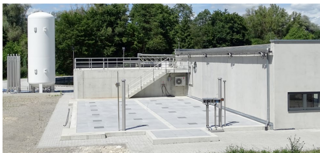
Varianta betonové nádrže HUBER Filtru s aktivním uhlím CONTIFLOW® GAK.
