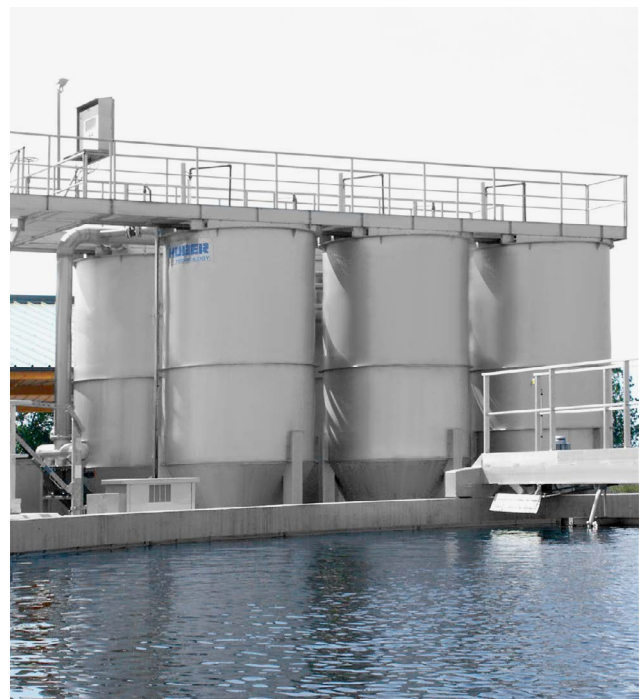
Tankversion des HUBER Aktivkohlefilter CONTIFLOW® GAK.
