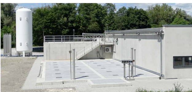
Beckenvariante des HUBER Aktivkohlefilter CONTIFLOW® GAK.
