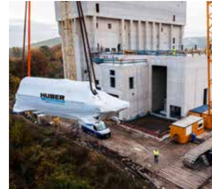
Installation von HUBER Scheibentrockner RotaDry®.
