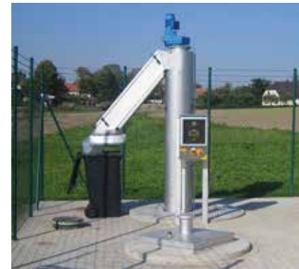
HUBER Schachtsiebanlage ROTAMAT® RoK4 in beheizter Freiluftaufstellung.
