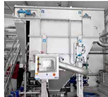
HUBER Druckentspannungsflotation HDF für das interne Wasserrecycling.
