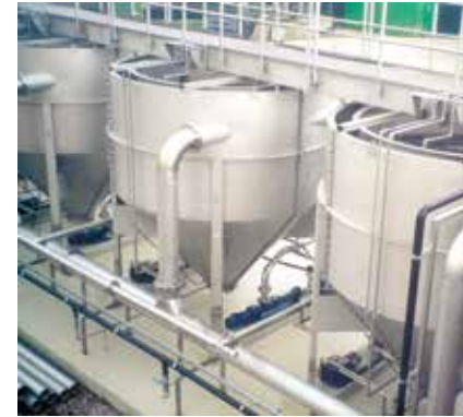
HUBER Rundsandfang HRSF im Betrieb.
