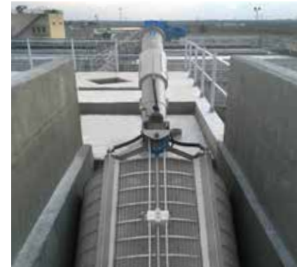
HUBER Siebanlage ROTAMAT® STAR zum Schutz von nachgeschalteten Membrananlagen.
