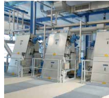
HUBER Harken-Umlaufrechen RakeMax®: zuverlässig und robust.
