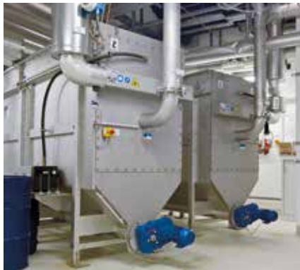
HUBER Abwasserwärmetauscher RoWin zur Energierückgewinnung.
