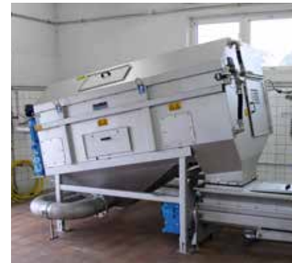
Betriebssichere Fäkalschlammannahme – die HUBER Fäkalannahmestation RotaShield®.
