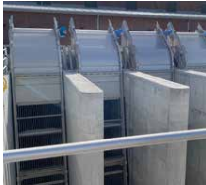
Robuste Rechentechnik für die Grobstoffentnahme: HUBER Grobrechen TrashMax®.
