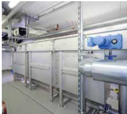
Abwasserwärmetauscher RoWin für Energierückgewinnung.
