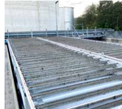
Flotation HDF S für hohe Feststofffrachten.
