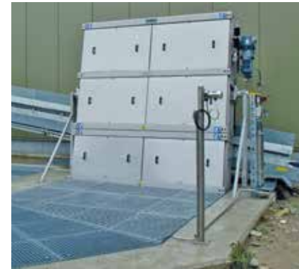
HUBER Harken-Umlaufrechen RakeMax® zur Flusswassersiebung in der Papierindustrie.
