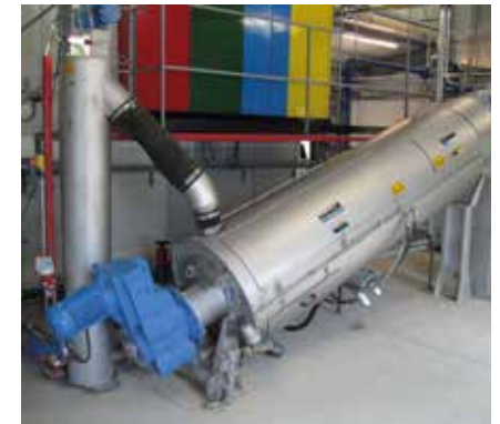
HUBER Schneckenpresse S-PRESS: spezifischer Leistungsbedarf < 0,01 kWh/kg TR .
