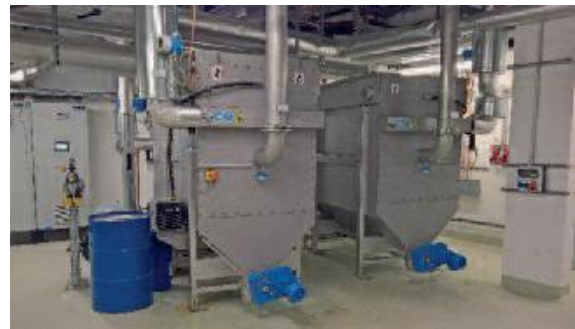
Abbildung 36: Abwasserwärmenutzung - das Museum „Haus der Bayerischen Geschichte“ in Regensburg (Bild oben © Bilddokumentation Stadt Regensburg) nutzt das HUBER ThermWin Verfahren mit den HUBER Abwasserwärmetauschern RoWin (Bild rechts) zum Heizen und Kühlen des Gebäudes. Damit werden fossile Energieträger durch regenerative Abwasserenergie ersetzt.
