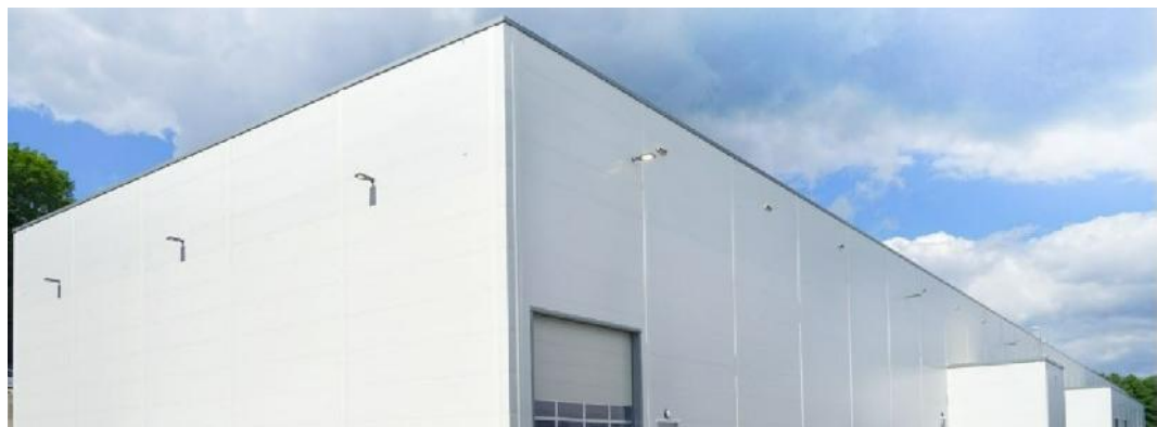
Abbildung 20: Die neue Montage - und Logistikhalle P4 mit einer Fläche von 5.500 m 2 wurde 2024 fertiggestellt und in Betrieb genommen.
