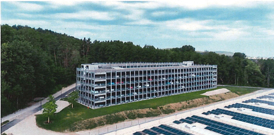
Abbildung 14, Parkhaus HUBER SE
