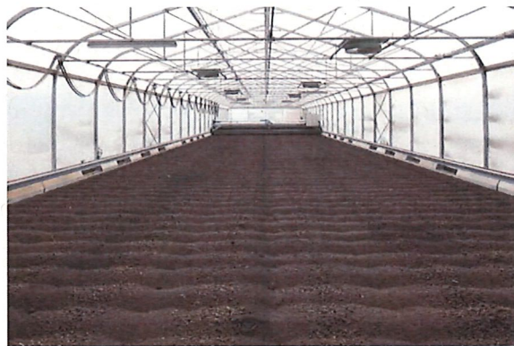
Abbildung 15, beim solaren-regenerativen Trocknungsverfahren nutzt HUBER die Sonnenenergie um Klärschlamm zu trocknen. Fossile Energieträger können somit eingespart werden
