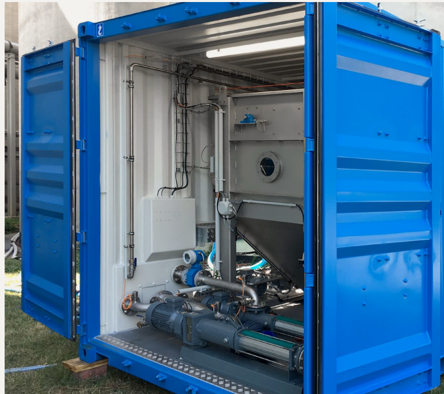
HUBER Druckentspannungsflotation HDF S2 zur Miete als Containeranlage.
