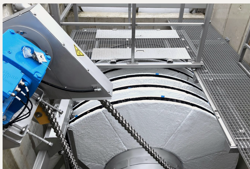
Der HUBER Tuchfilter RotaFilt® schützt auf der Kläranlage Bickenbach die Vierte Reinigungsstufe und kann als Flockungsfiltration betrieben werden.
