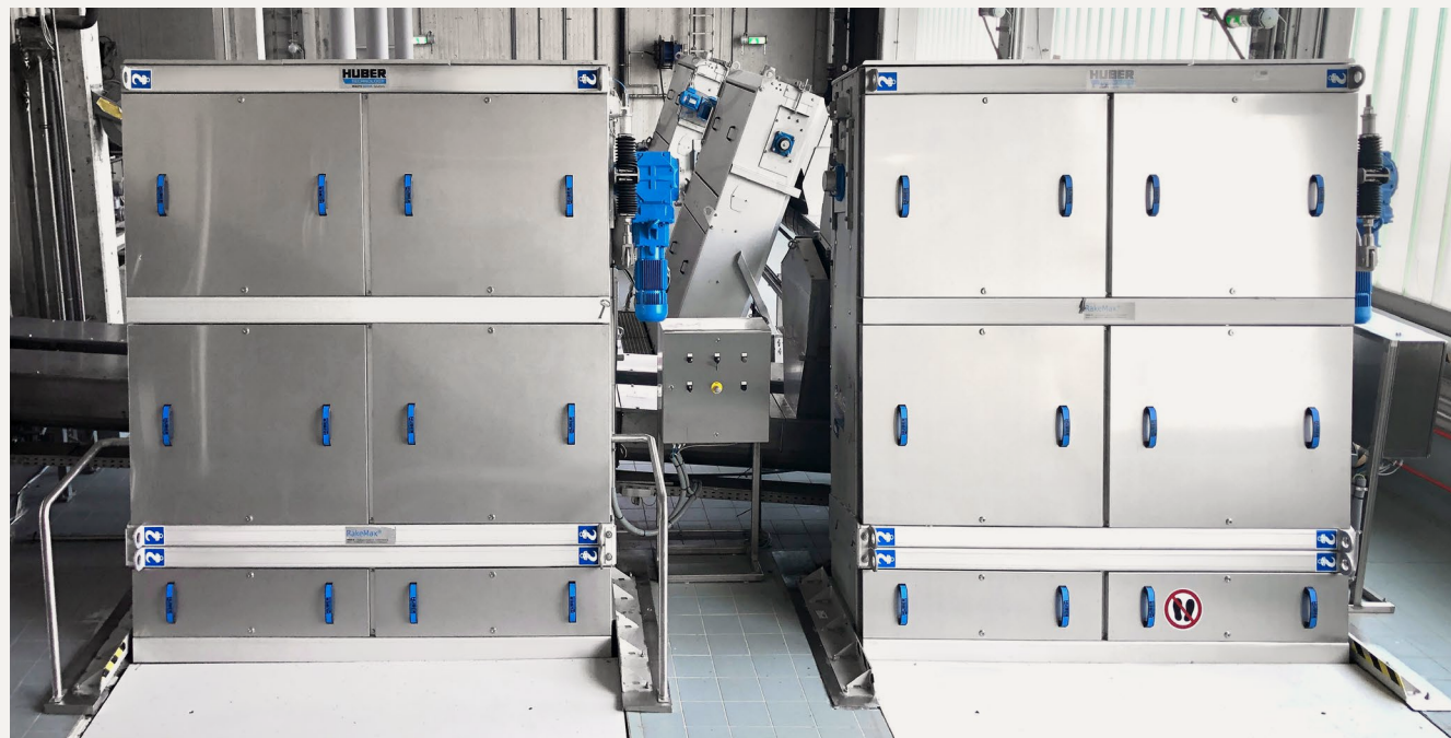
Zwei neue HUBER Harken-Umlaufrechen RakeMax® auf der Kläranlage Villach.
