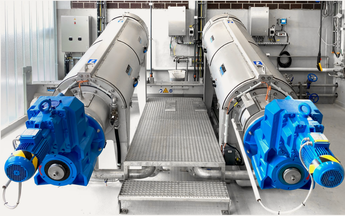
Effiziente Klärschlammwässerung: Neben dem neuen Rechen wurden auf der Kläranlage Detmold auch zwei HUBER Schneckenpressen Q-PRESS® installiert.
