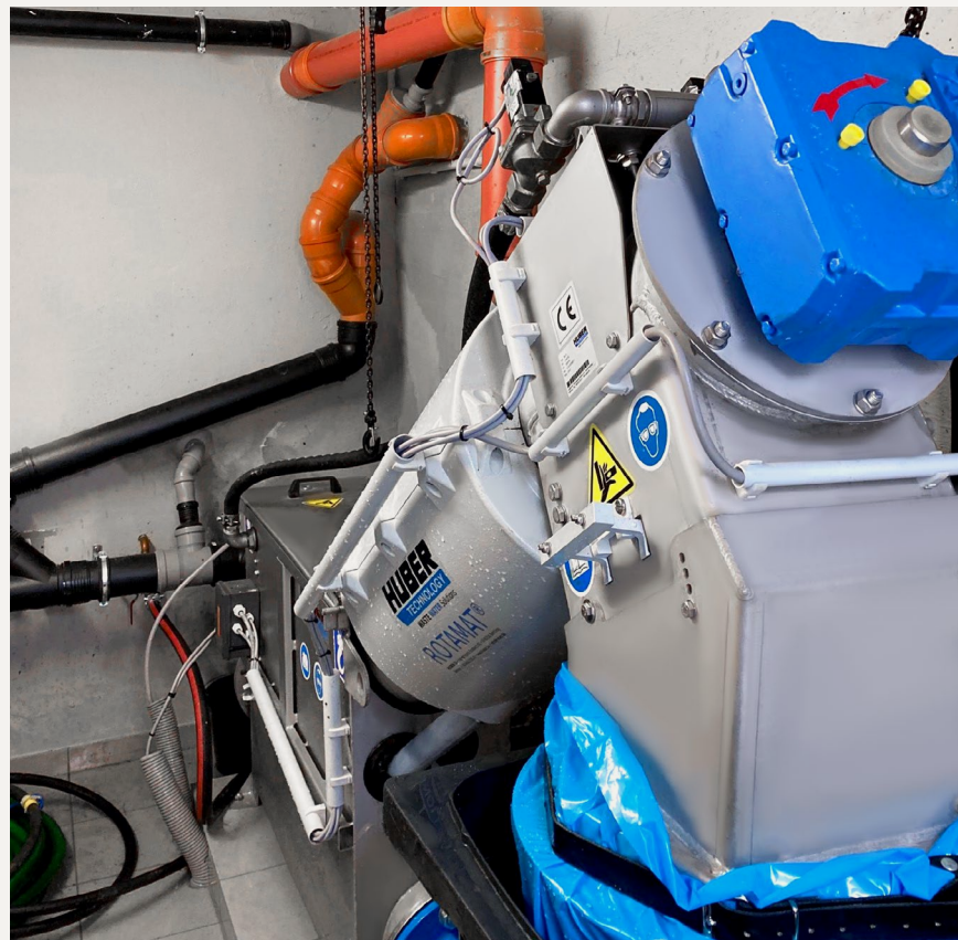
Die HUBER Siebschnecke ROTAMAT® Ro9 auf der Bremer Hütte.
