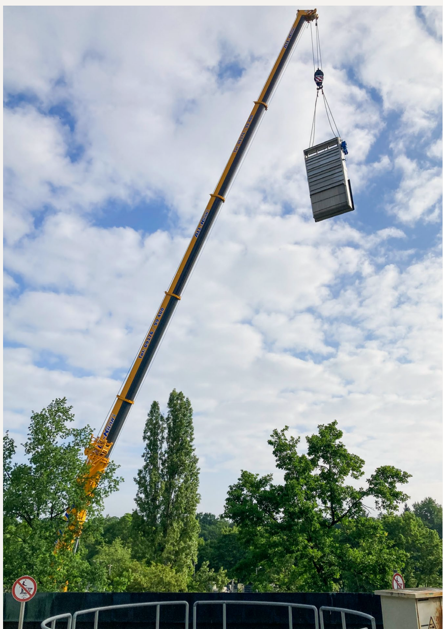
Die Montage der Rechenanlagen auf dem Klärwerk Nürnberg II erfolgte mithilfe eines 100-Tonnen-Krans.
