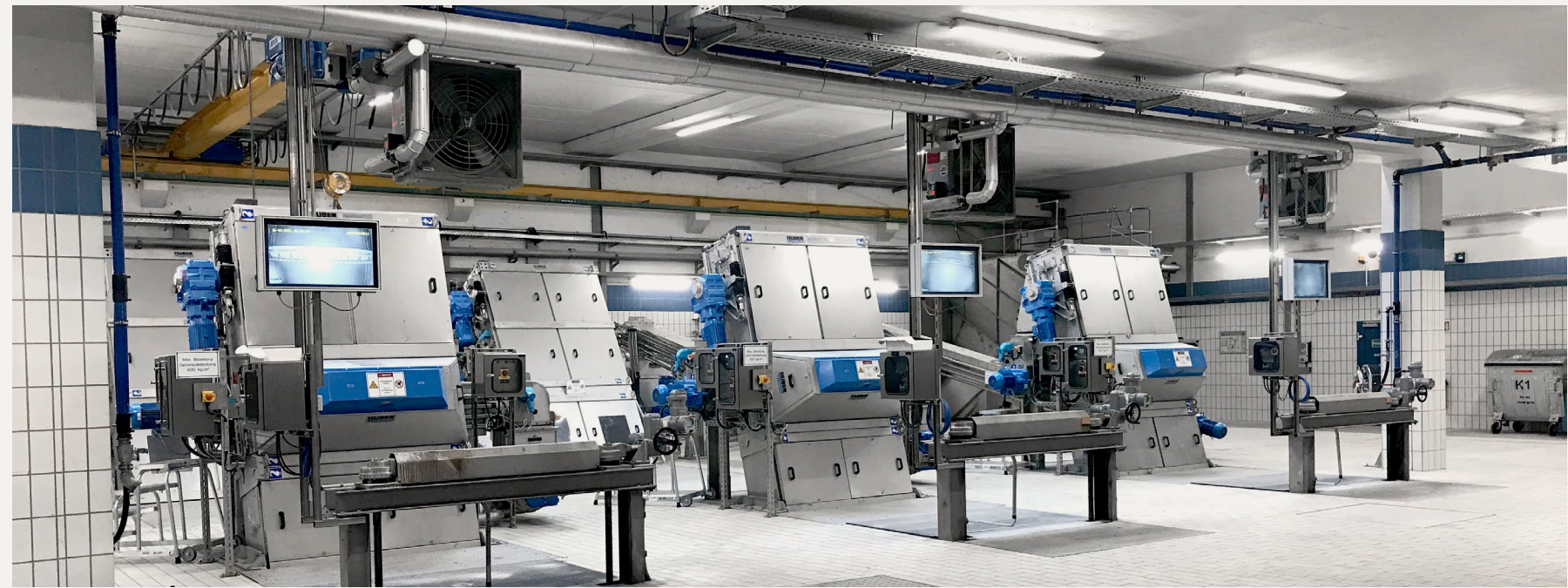
Rechenanlage auf dem Klärwerk Nürnberg I: HUBER Harken-Umlaufrechen RakeMax® mit Störstofferkennung Safety Vision.
