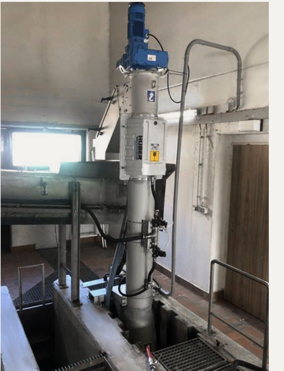
HUBER Schachtsiebanlage ROTAMAT® RoK4.
