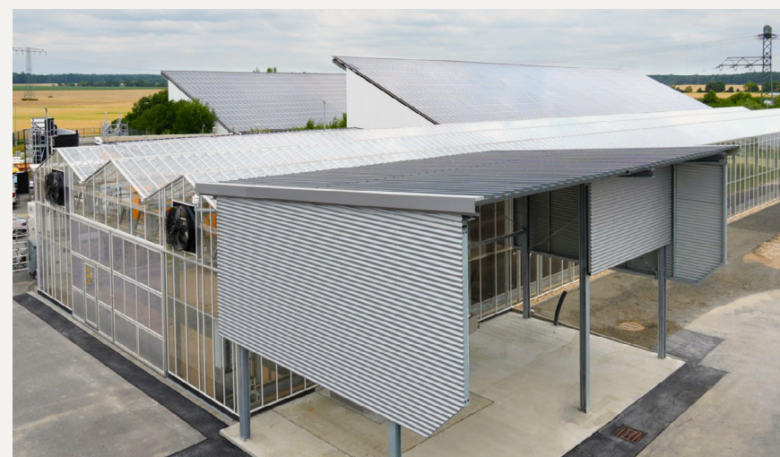
Die Kläranlage Kodersdorf mit einer Ausbaugröße von 7.500 EW ist die erste solare Klärschlamm-trocknungsanlage mit dem neuen HUBER Schlammwender SOLSTICE® FloorRunner.
