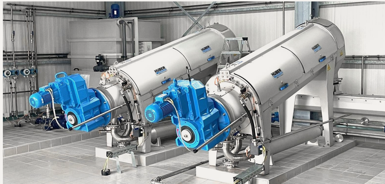
Zwei HUBER Schneckenpressen Q-PRESS® auf der Kläranlage Regen.
