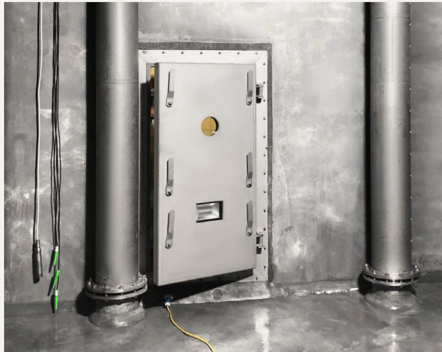
HUBER Drucktür TT7, nachträglich eingebaut.
