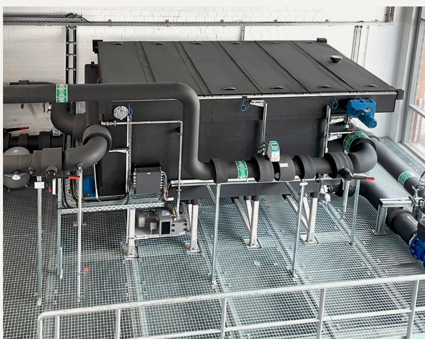
Der HUBER Abwasserwärmetauscher RoWin14, durch die Schwitzwasserisolierung nicht in typischer Edelstahloptik, sondern in Schwarz (© SES).
