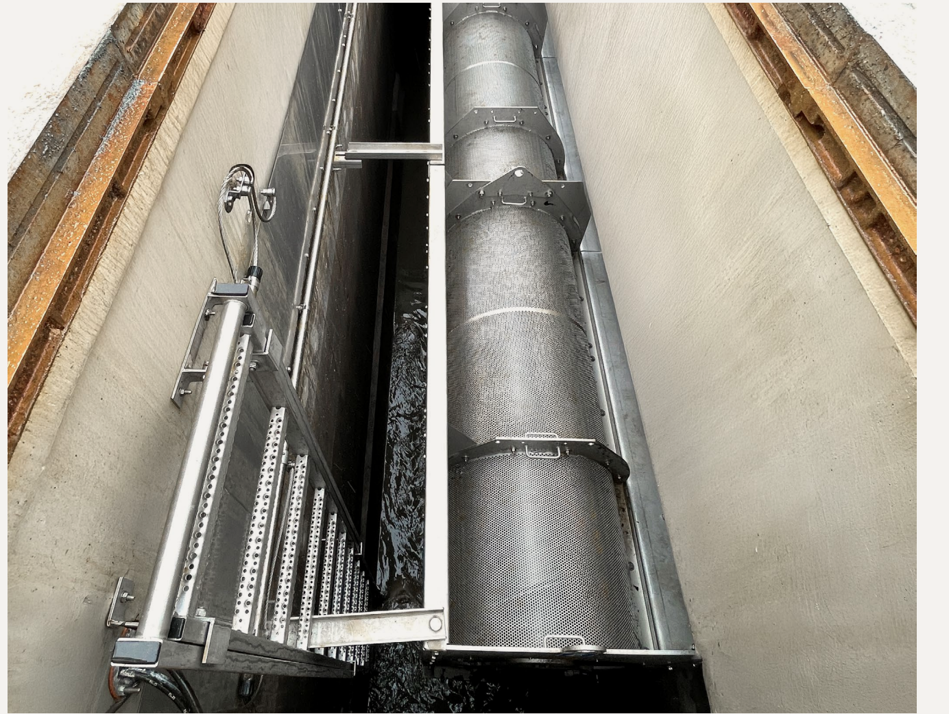
HUBER Siebanlage ROTAMAT® RoK2, BG 700 im Durchlaufbecken Röthenbacher Straße in Wendelstein.
