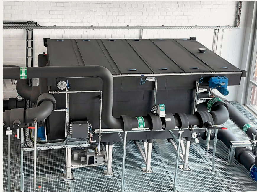
Der HUBER Abwasserwärmetauscher RoWin14, installiert auf einer Stahlbühne im Heizkraftwerk. Durch die Schwitzwasserisolation nicht in typischer Edelstahloptik, sondern in Schwarz (© SES Energiesysteme GmbH).
