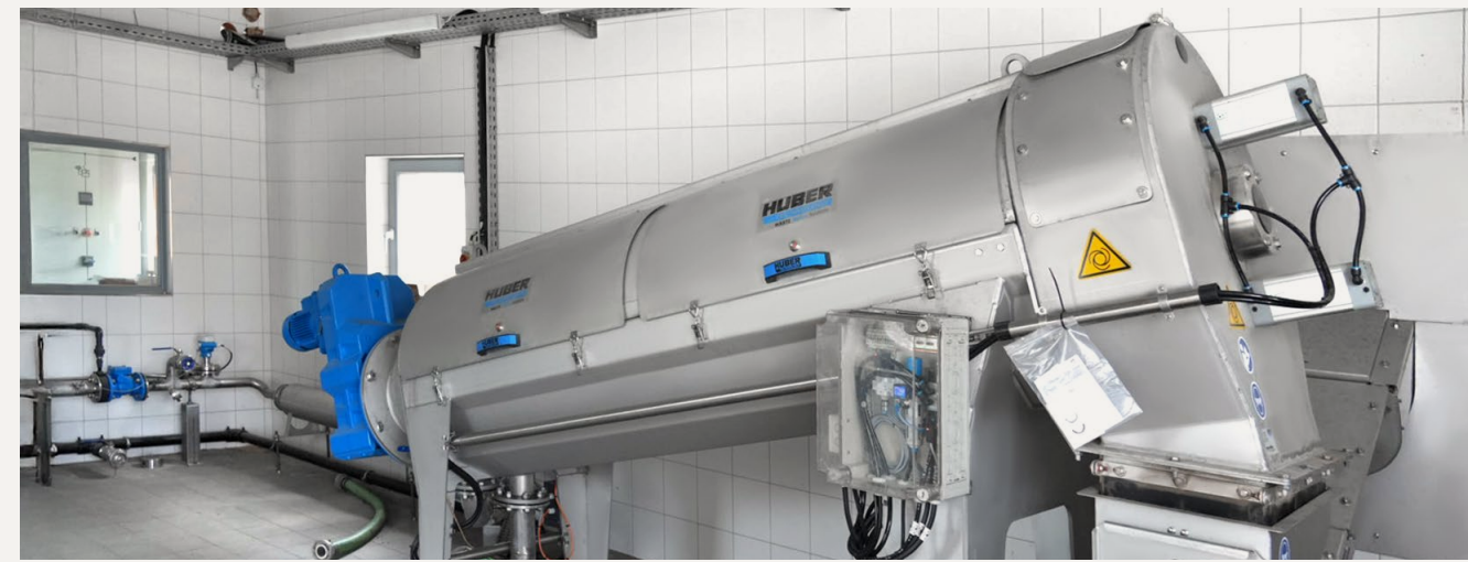
Eine HUBER Schneckenpresse Q-PRESS® 440 entwässert knapp 150 t Trockenmasse auf über ca. 20 – 23 % Trockenrückstand. Den entwässerten Klärschlamm fördert eine HUBER Trogförderschnecke Ro8 TSF in den solaren Klärschlamm-trockner.
