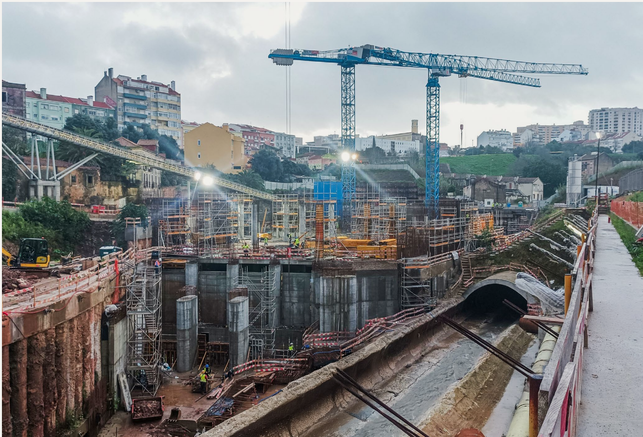
Mit einer Länge von exakt 4.975 Metern und einem Innendurchmesser von 5,5 Metern wurde der Tunnel so ausgelegt, dass er Wassermengen von bis zu 40 Kubikmetern pro Sekunde bewältigen kann.
