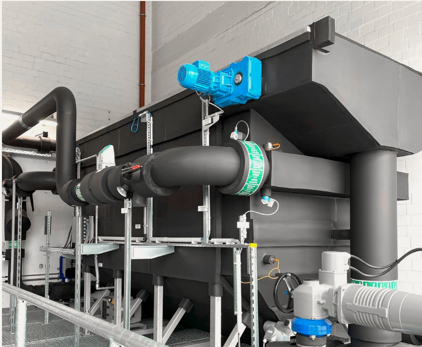
Der HUBER Abwasserwärmetauscher RoWin entzieht dem Flusswasser bis zu 780 kW und stellt somit emissionsfreie Energie zur Verfügung (© SES Energiesysteme GmbH).
