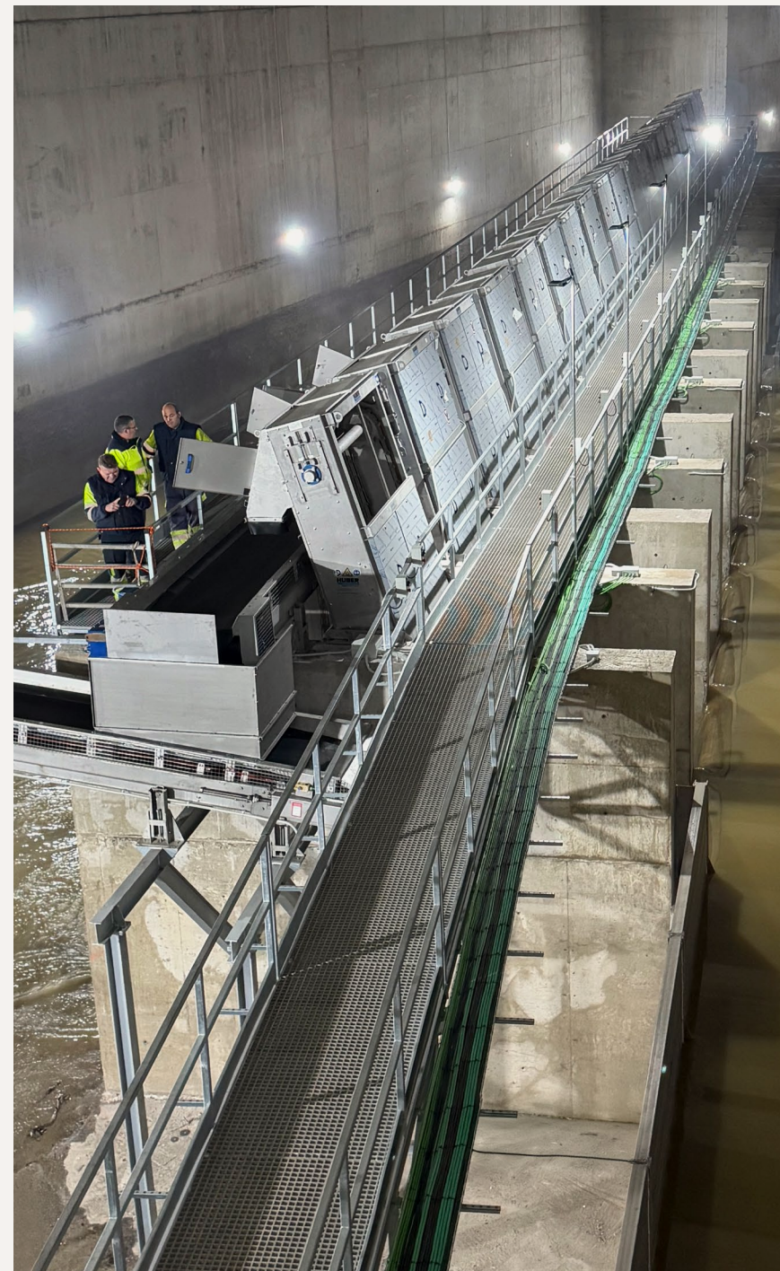
20 HUBER Harken-Umlaufrechen RakeMax® im Regenrückhaltebecken Abronigales.
