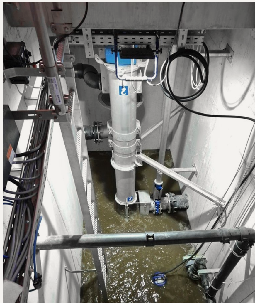
HUBER Schachtsiebzanlage ROTAMAT® RoK4.
