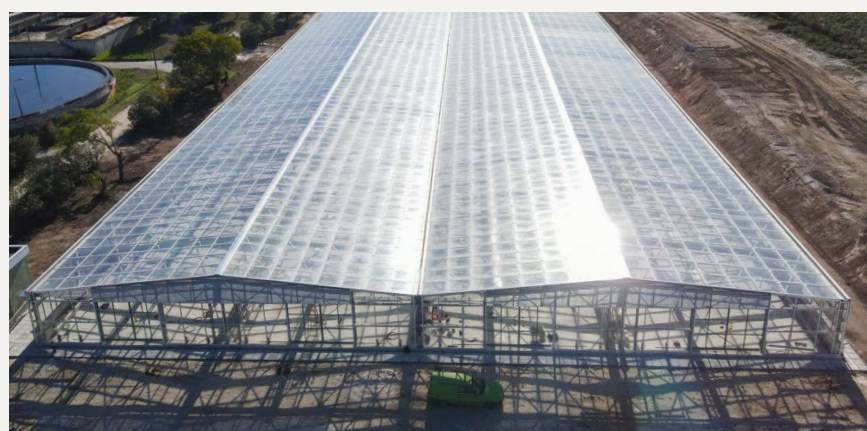
In Griechenland werden bereits mehrere solare Klärschlamm-trockner betrieben – hier die Anlage in Larissa.
