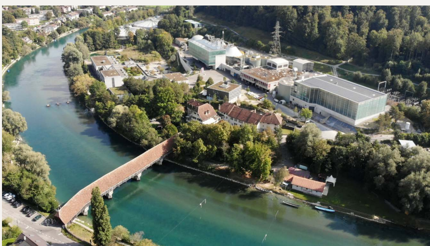
Die Anlage behandelt das Abwasser von rund 225.000 Einwohnern in zwölf Berner Gemeinden sowie von Industrie- und Gewerbebetrieben im Einzugsgebiet. © ara region bern AG
