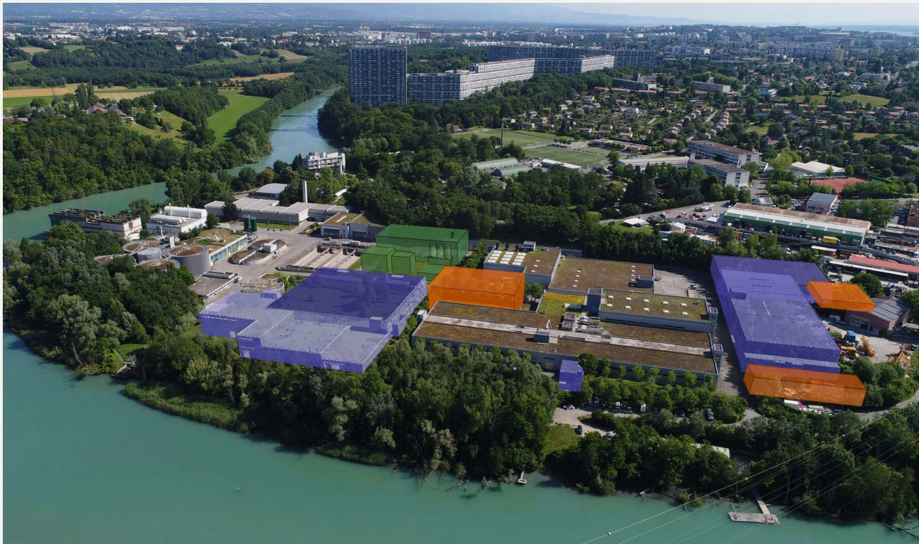
Standortübersicht mit den geplanten Maßnahmen: Erweiterung Abwasserreinigung (blau), Ausbau Schlammbehandlung (grün) sowie Installation von Wärmepumpen und zugehörigen Anlagen (orange). © Université de Genève | SIG
