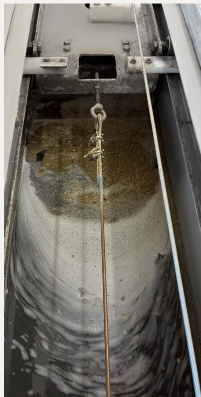
Abbildung 1: HUBER Kompaktanlage ROTAMAT® Ro5 mit Fettfangtasche nach Stand der Technik und Paddelräumer.
