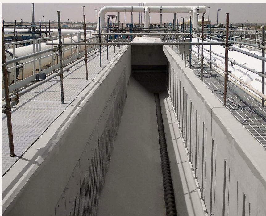
42 m langer HUBER Langsandfang ROTAMAT® Ro6 mit Schneckenräumung.
