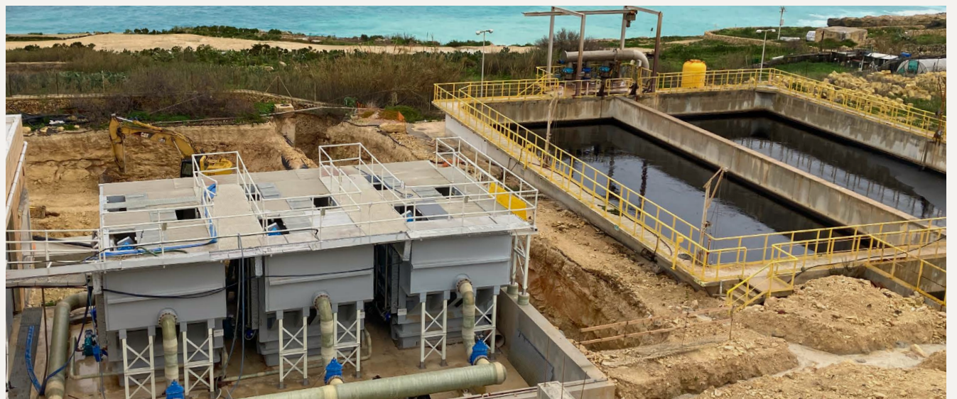
Die drei HUBER Tuchfilter RotaFilt® sind in Behälter verbaut.
