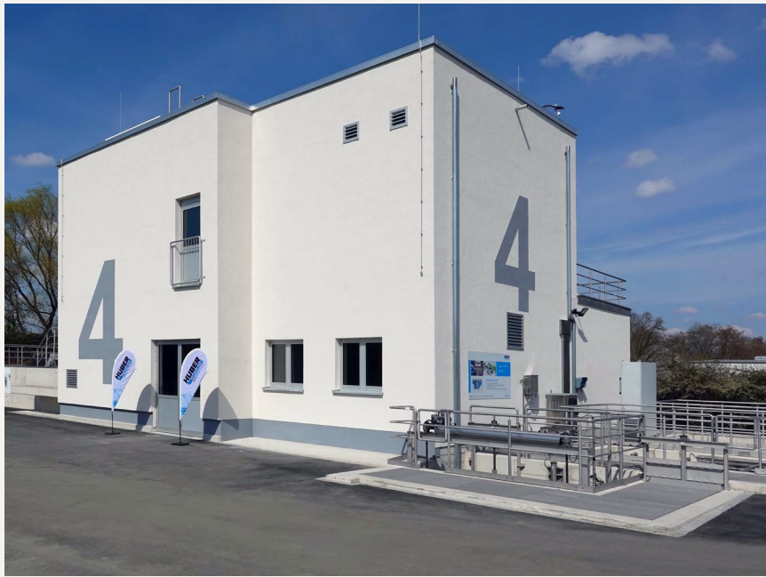
Die Vierte Reinigungsstufe der Verbandskläranlage Bickenbach behandelt bis zu 150 l/s Abwasser und hält den größten Anteil der Mikroverunreinigungen zurück.
