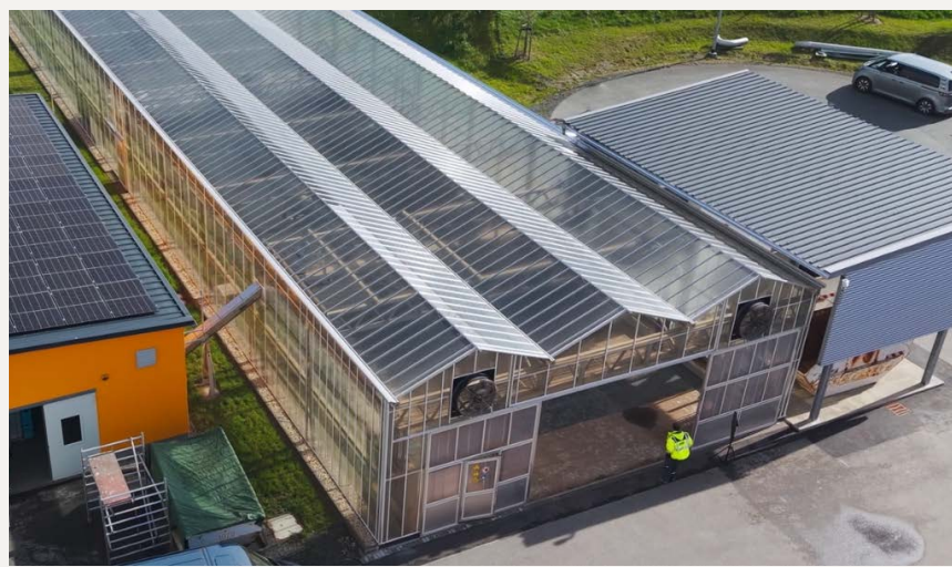
Übersicht über die fertige Anlage.
