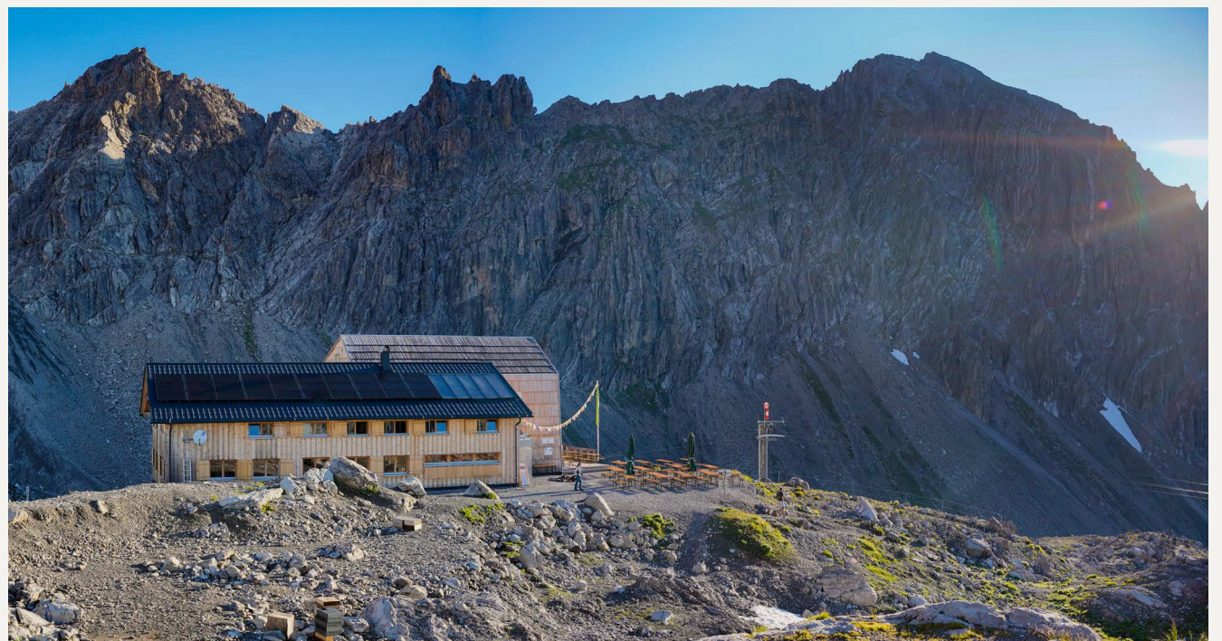
Die Totalphütte liegt auf 2.385 m. Eine HUBER Siebschnecke ROTAMAT® Ro9 reinigt dort zuverlässig das Abwasser der Tages- und Übernachtungsgäste.
