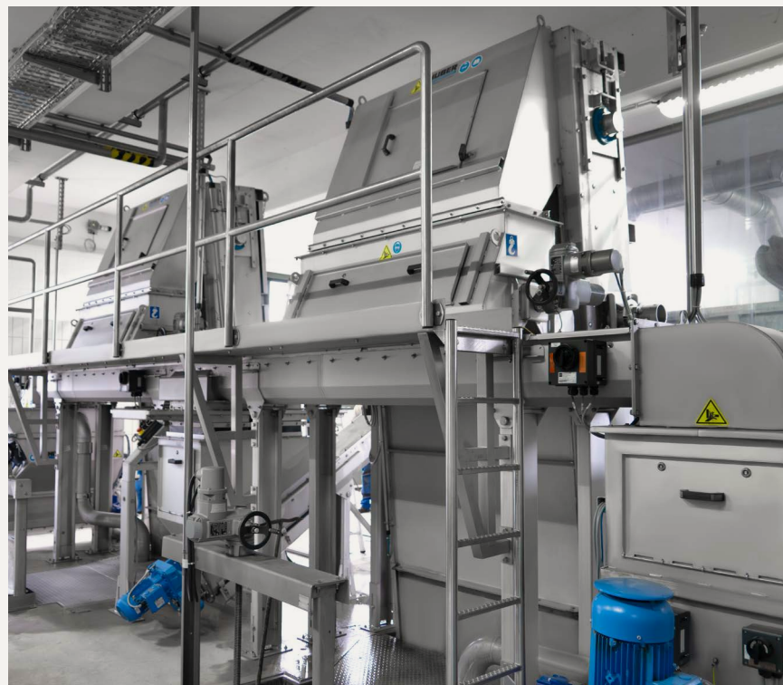
Die beiden kürzlich gewarteten HUBER Harken-Umlaufrechen RakeMax®.
