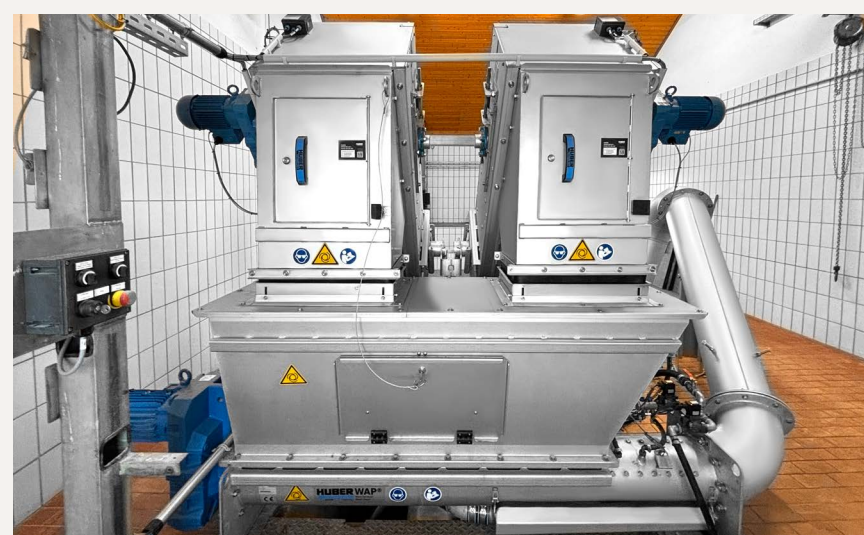
Auf der Kläranlage Stemwede wurden zwei HUBER Harken-Umlaufrechen RakeMax® installiert.
