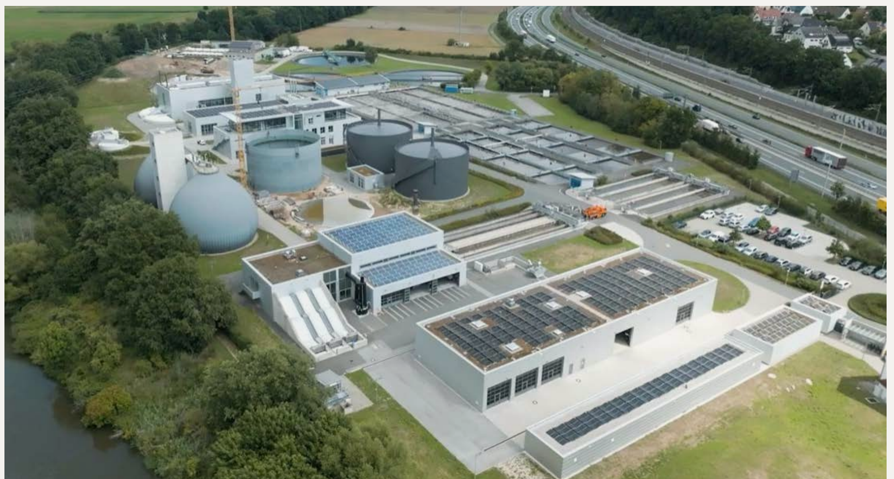
Überblick über die Kläranlage Erlangen.
