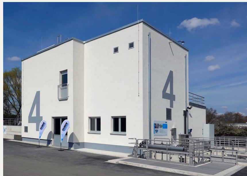
Die Vierte Reinigungsstufe der Verbandskläranlage Bickenbach behandelt bis zu 150 l/s Abwasser und hält den größten Anteil der Mikroverunreinigungen zurück.
