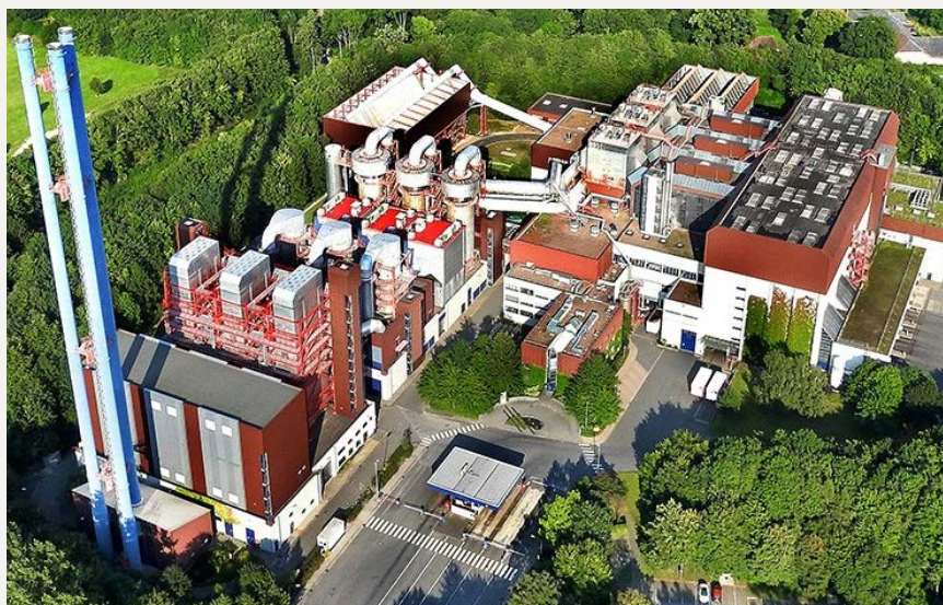
Luftaufnahme der MVA Bielefeld-Herford GmbH. © Interagem
