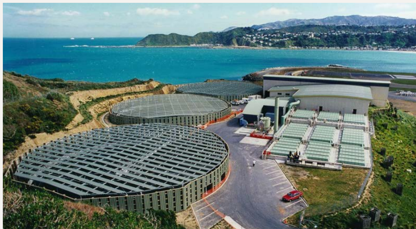
Umfassende Sanierung der Moa Point Abwasseraufbereitungsanlage. (© Wellington City Council und von WCC zur Wiederverwendung unter der Creative Commons Attribution 4.0 International licence lizenziert)
