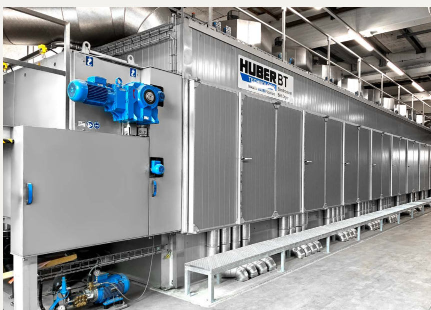
Der neue HUBER Bandtrockner BT auf der Anlage des AVA Altenrhein.
