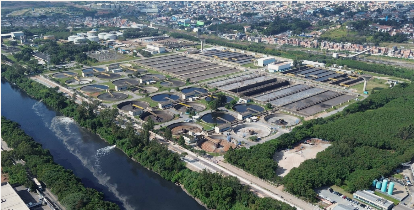
Die größte Kläranlage Südamerikas: Die Abwasserkapazität der ETE Barueri im Großraum São Paulo wird von derzeit 16 m 3 /s auf eine Kapazität von 22,5 m 3 /s und max. 34 m 3 /s erhöht.
