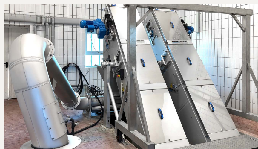
Für die mechanische Vorreinigung wurden die Rechentechnik und die Waschpresse erneuert.
