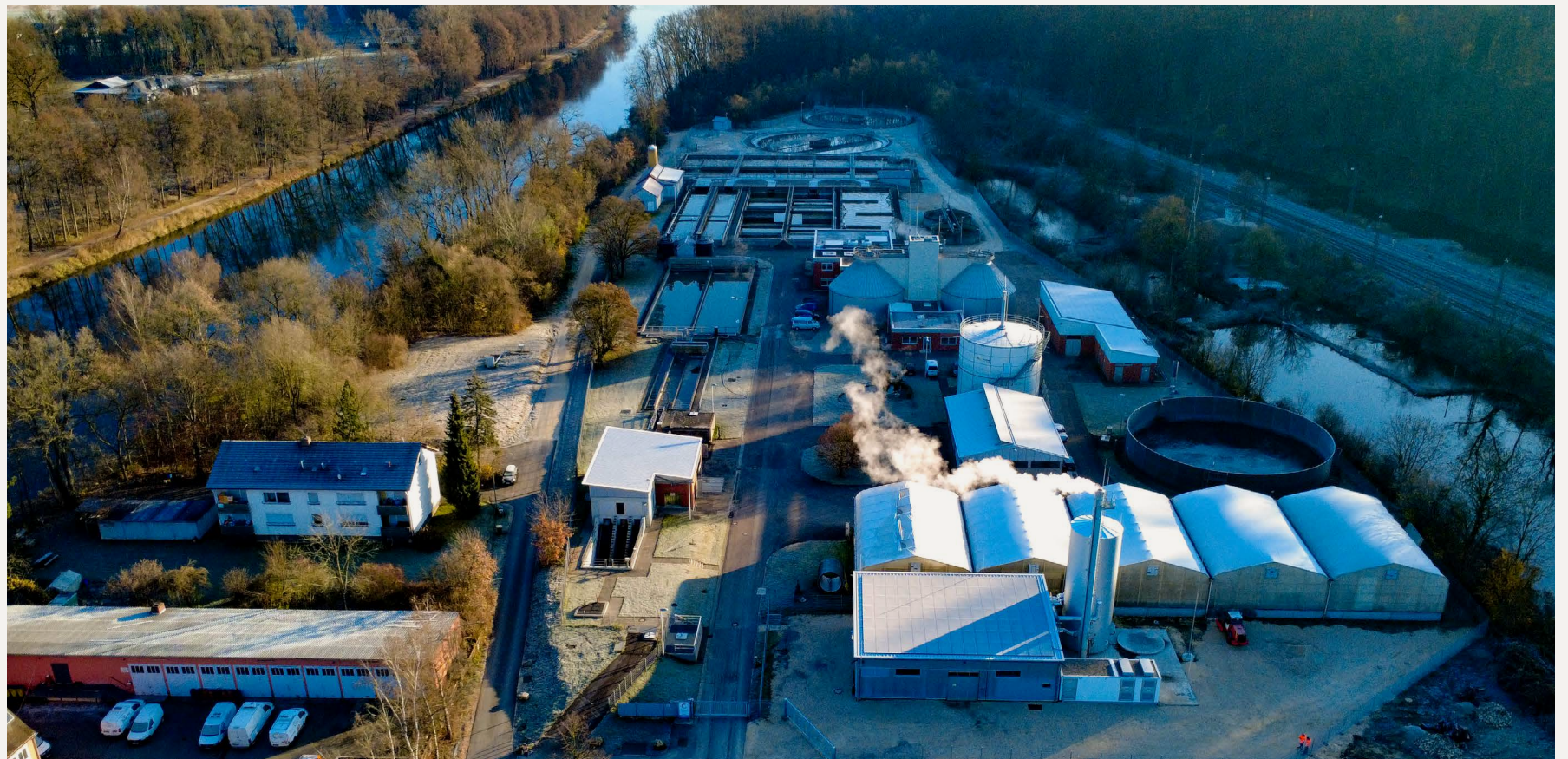
Die Kläranlage Günzburg (Schwaben).
