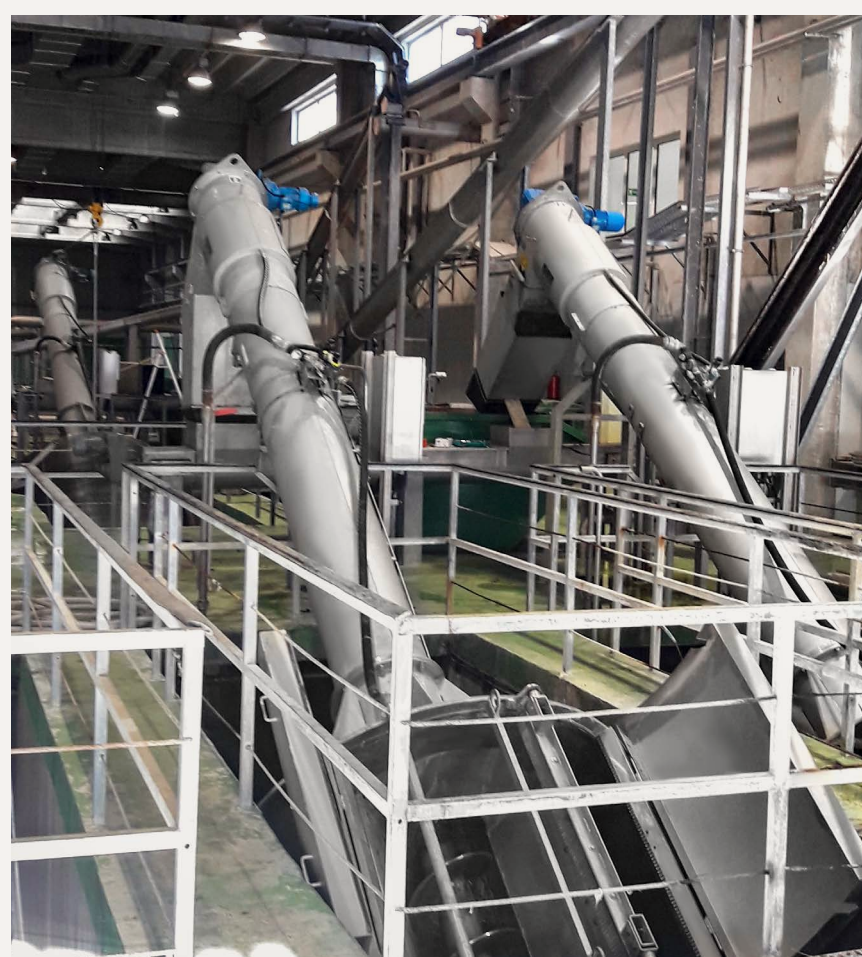
Auf der Kläranlage Stupe Split wird unter anderem die mechanische Vorreinigung erweitert.
