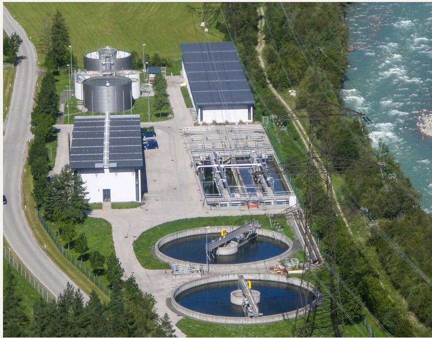
Übersicht über die Verbandskläranlage Huben-Kienburg. (© Abwasserverband Hohe Tauern Süd)
