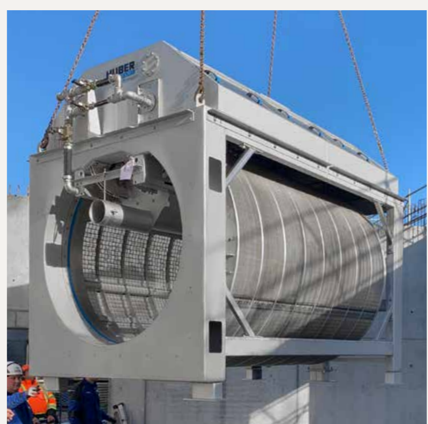
Ein HUBER Trommelsieb LIQUID beim Einbau.
