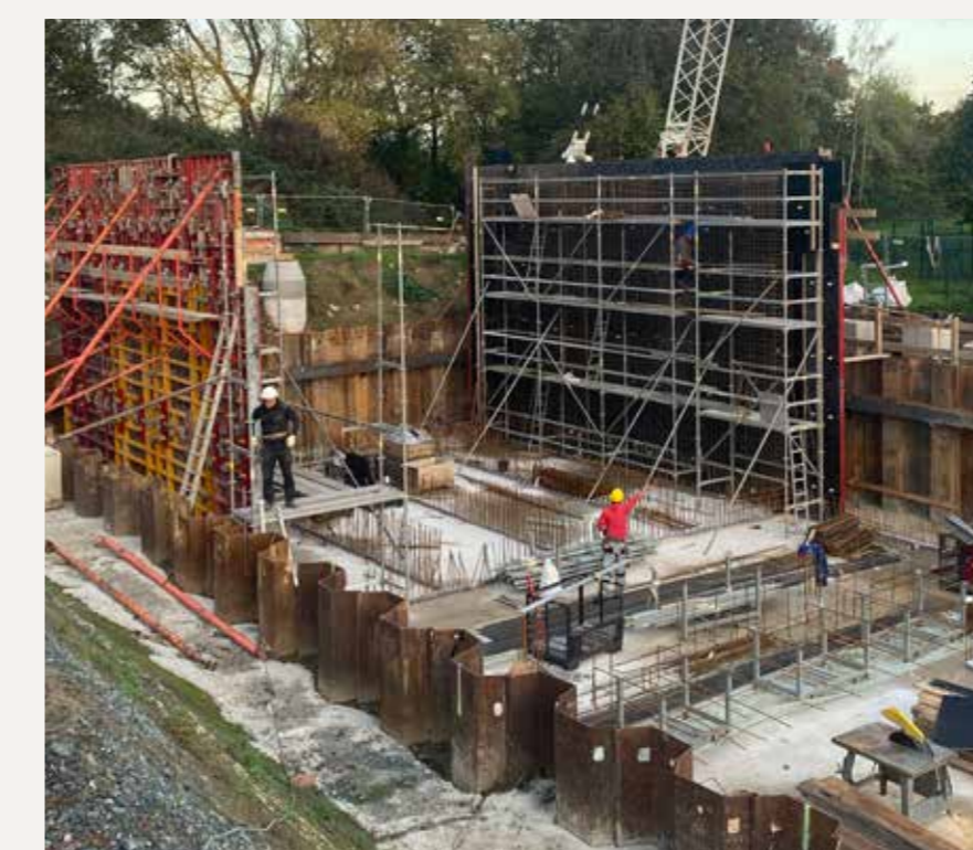
Der Bau der Aktivkohlefilter-Stufe in Bickenbach schreitet voran.
