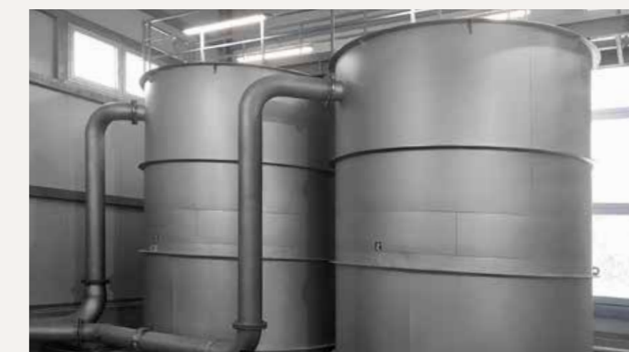
In Fridingen (Baden-Württemberg) bereits seit 2020 in Betrieb: Die Vierte Reinigungsstufe bestehend aus zwei HUBER Aktivkohlefiltern CONTIFLOW® GAK.
