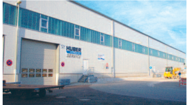
HUBER SE Service-Werksreparaturhalle
