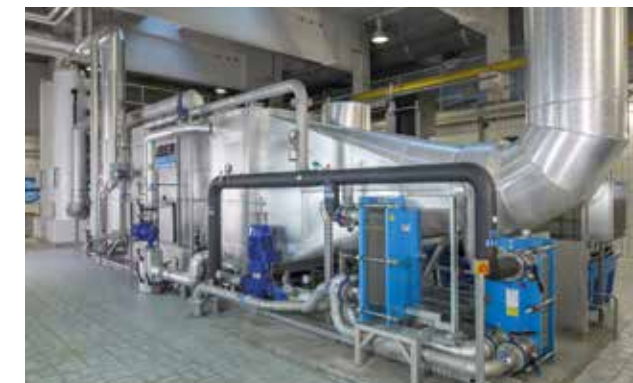
Estágio de condensação com extração de calor e limpeza totalmente automática do trocador de calor.
