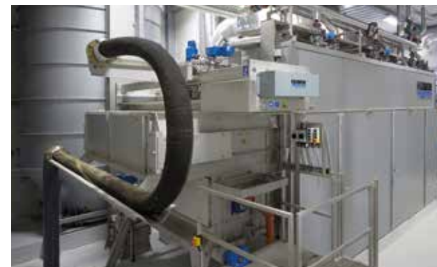
Alimentação de lodo com extrusora HUBER.
