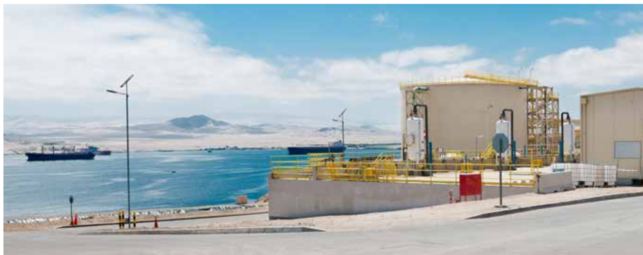
Usina de dessalinização na área de Punta Padrones, na cidade de Caldera (Atacama), no Chile.
