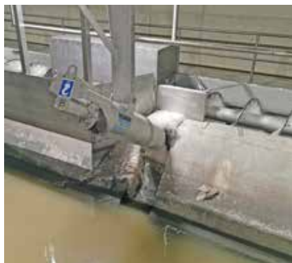
Tela fluvial ROTAMAT® RoK1 TS HUBER para a remoção confiável de peneirados.
