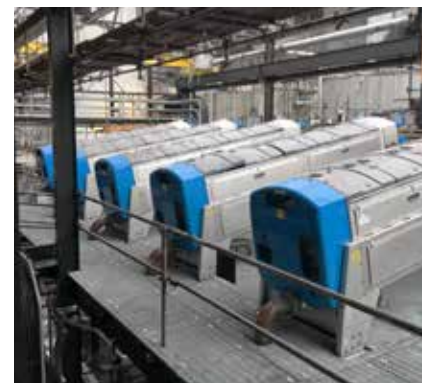
Desidratação de lodo com prensa de hélice Q-PRESS® 800.2 HUBER.
