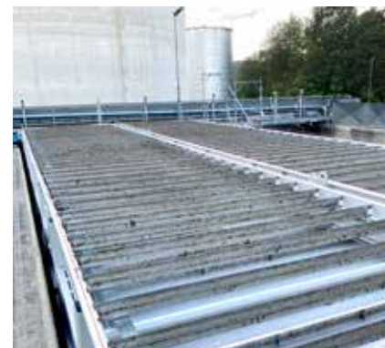
Estação de flotação HDF S para altas cargas de sólidos.
