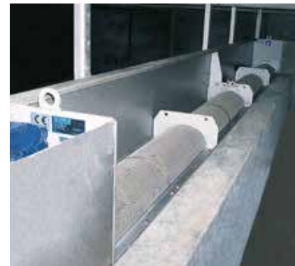
Tela de águas pluviais ROTAMAT® RoK2 HUBER instalada no lado da água suja da barragem de transbordamento.
