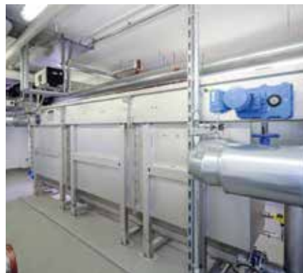
Trocador de calor RoWin para recuperação de energia.
