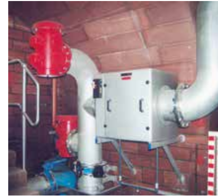
Estação de filtragem de ar HUBER para água potável limpa.
