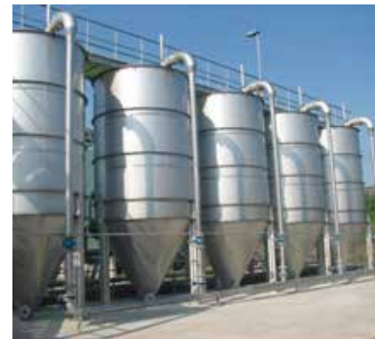
Filtro de areia CONTIFLOW® HUBER, design em aço inoxidável.
