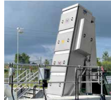
Tela HUBER com corrente de apoio rígida para máxima confiabilidade de operação.
