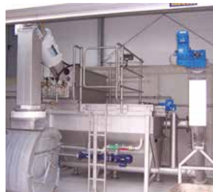
Tratamento mecânico de águas residuais em espaços confinados.
