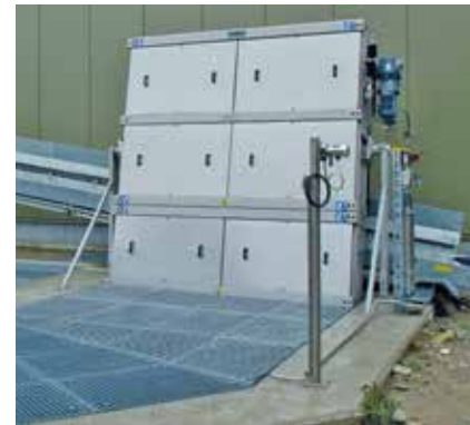
Grade multirrastelos RakeMax® HUBER para triagem de água de rios na indústria de papel.
