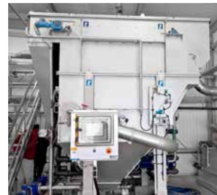
Usina de flotação por ar dissolvido HDF HUBER para reciclagem interna de água.
