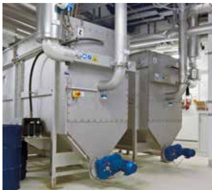
Trocador de calor RoWin HUBER para recuperação de energia.
