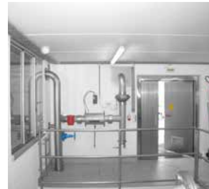
Sistema HUBER completo com ventilação forçada ativa.
