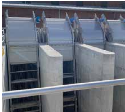
Tela robusta para remoção de material grosso: Tela grossa TrashMax® HUBER.
