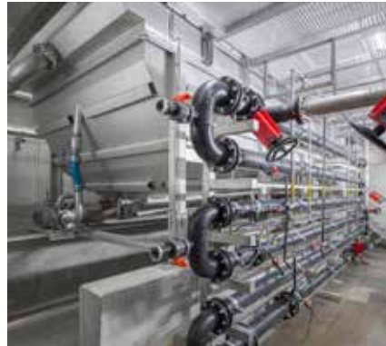
Planta de flotação por ar dissolvido para tratamento confiável de águas residuais.
