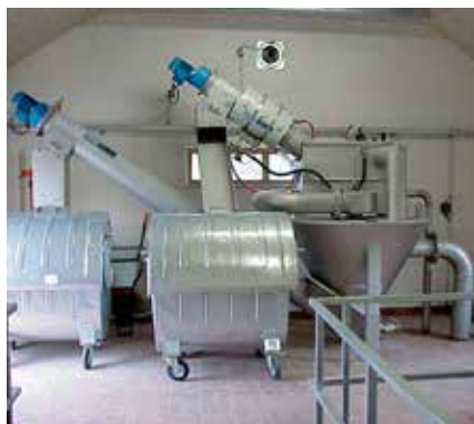
Cabeçotes completos em uma única unidade vedada e compacta, ideais para estações pequenas.
