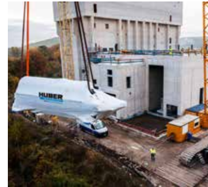
Um secador de disco RotaDry® HUBER durante a instalação no local.
