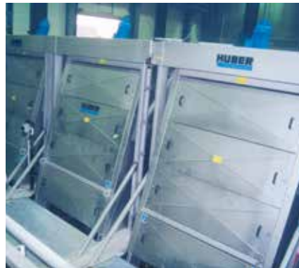
Tela fina STEP SCREEN® SSV HUBER - a melhor STEP SCREEN®.
