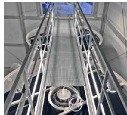
Filtro de carvão ativado Contiflow® GAK HUBER, design em aço inoxidável, para a remoção de substâncias residuais.
