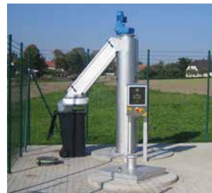
Tela para estações de bombeamento ROTAMAT® RoK4 HUBER com aquecimento para instalação em ambientes externos.
