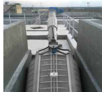
Tela de placa perfurada ROTAMAT® STAR HUBER para proteção dos sistemas de filtragem por membrana a jusante.
