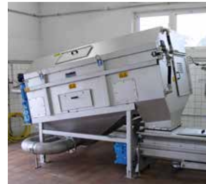
Sistema de aceitação de lodo fecal confiável – a estação de aceitação de lodo RotaShield® HUBER.
