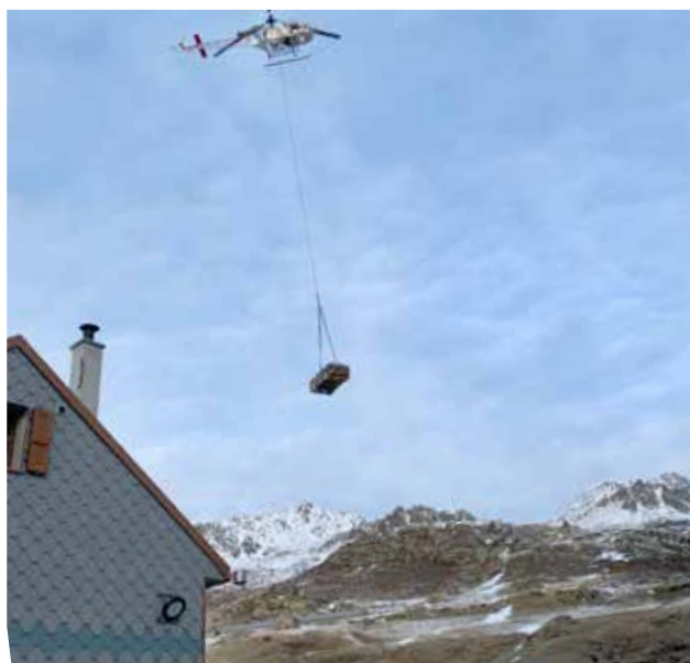
Implementação de projetos mesmo em locais de difícil acesso.
