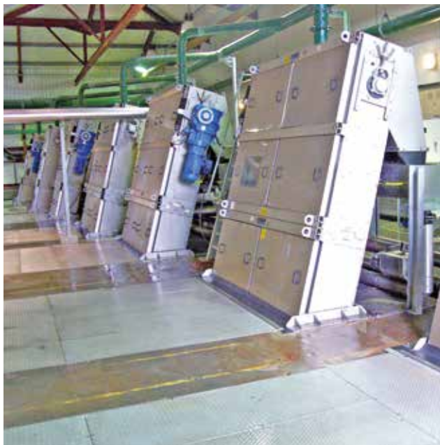
Peneira RakeMax® HUBER de aplicação universal para grandes larguras de canal e grandes alturas de descarga.
