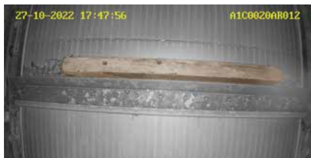
Imagens ilustrativas para notificação do operador - almofada de vedação do tubo (esquerda) e madeira quadrada (direita) na barra do rastelo de uma grade multirrastelos RakeMax® HUBER.
