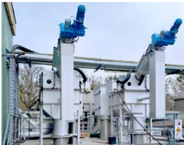
Instalação externa de peneiras finas ROTAMAT® Ro1 HUBER com aquecimento para proteção contra congelamento.
