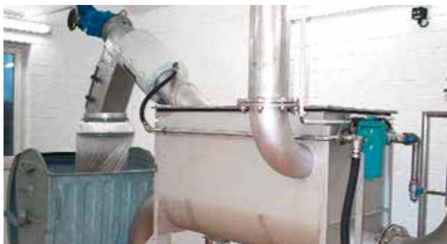
Peneira fina de tambor rotativo ROTAMAT® HUBER montada em tanque...
