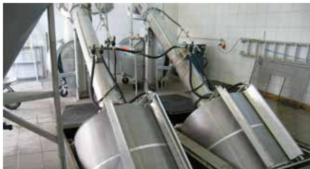
Requisito de espaço reduzido devido ao uso de duas peneiras finas de tambor rotativo ROTAMAT HUBER no canal, tamanho 1400.
