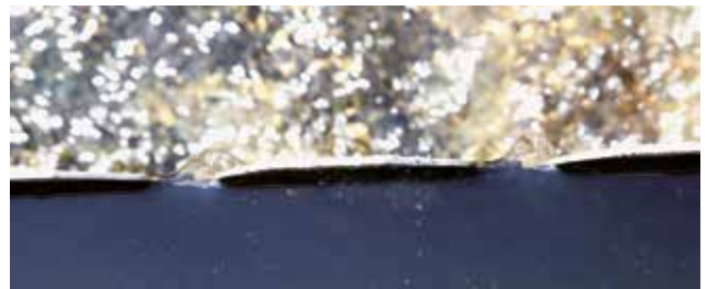
Os flocos de lodo ativado as vezes são retidos de forma ineficiente pelo clarificador secundário.
