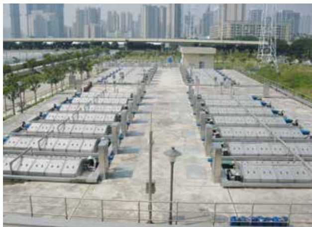
28 unidades de filtro de disco RoDisc® HUBER com 24 discos cada, tratando cerca de 8,5 m³ de águas residuais por segundo.
