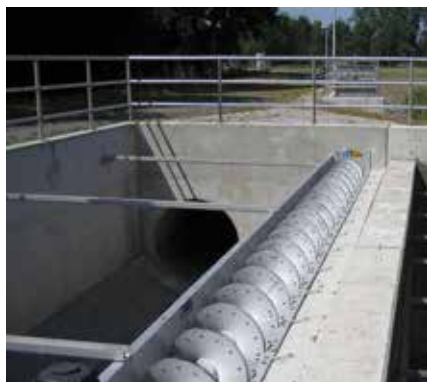
HUBER Čištění na přepadech ROTAMAT® RoK1 instalované na suché straně přepadu.
