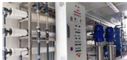
Fáze konečných úprav pro odstranění salinity.
