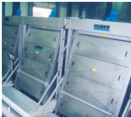
HUBER jemné česle STEP SCREEN® SSV – vylepšené česle STEP SCREEN®.
