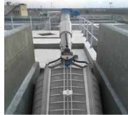
HUBER síto s perforovaným plechem ROTAMAT® STAR chrání následné membránové filtrační systémy.
