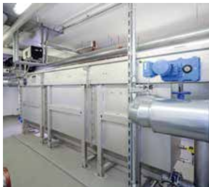
Výměník tepla RoWin pro rekuperaci energie.
