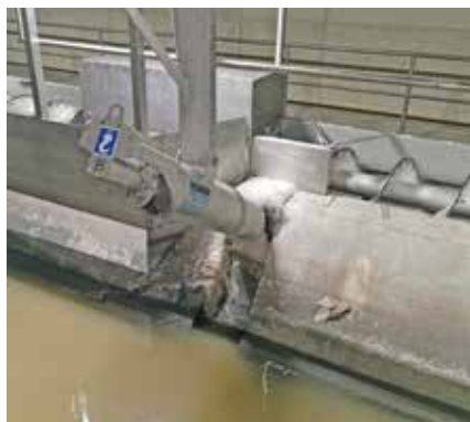
HUBER Čištění na přepadech ROTAMAT® RoK1 TS pro spolehlivé odstraňování shrabek.
