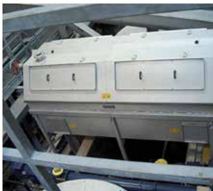
HUBER rotační síto RoMesh® pro odstranění jemného a nejjemnějšího materiálu.
