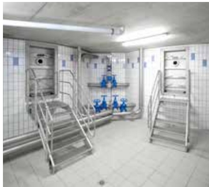
Tlakotěsné dveře HUBER pro bezpečný přístup k nádržím.
