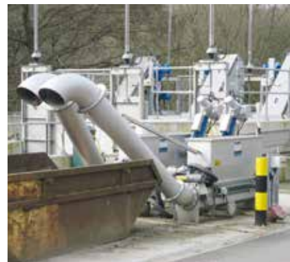
HUBER lis na shrabky WAP® L se systémem podávání pracím žlabem: redundantní provoz a optimální odvodnění shrabků.
