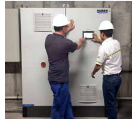
Předání know-how personálu obsluhy za účelem optimálního provozu celého zařízení.
