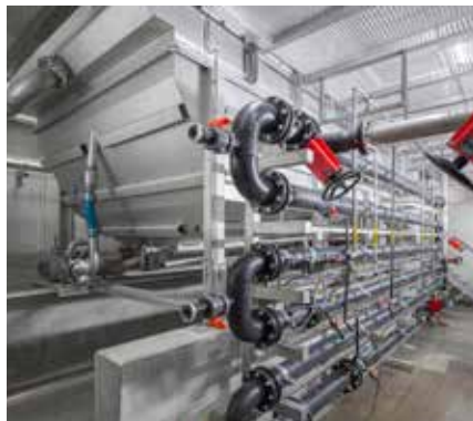
Zařízení na flotaci rozpuštěným vzduchem pro spolehlivou úpravu odpadních vod.
