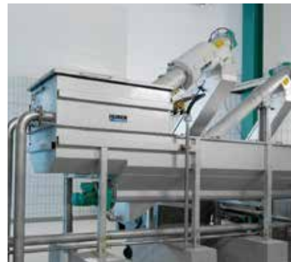
UBER fekální stanice ROTAMAT® Ro3.3, prověřená ve stovkách instalací po celém světě.
