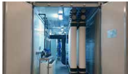
Fáze předběžné úpravy s využitím ultrafiltrace pro odstranění suspenzí.
