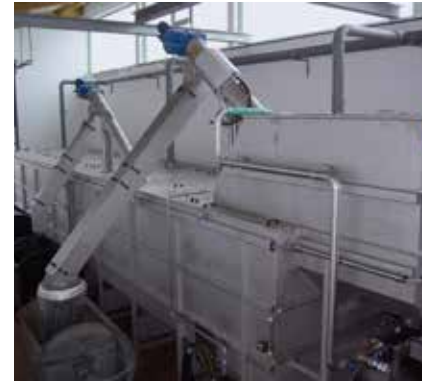
Kompletní mechanické čištění odpadních vod v jednom kompaktním zařízení.
