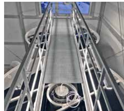
Filtr s aktivním uhlím HUBER Contiflow® GAK, nerezová konstrukce, pro odstraňování stopových látek.
