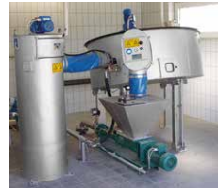
Jedinečný zahušťovač: HUBER kruhový zahušťovač kalu S-DISC.
