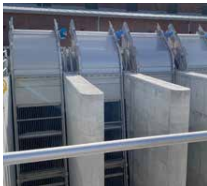
Robustní síto k odstranění hrubých nečistot: HUBER hrubé síto TrashMax®.
