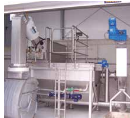
Mechanické čištění odpadních vod ve stísněných prostorách.
