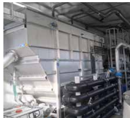
Systém HUBER flotace rozpuštěným vzduchem HDF pro redukci tuků a pevných látek před nepřímým vypouštěním.
