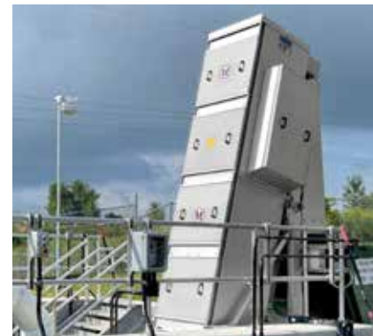
Síto HUBER s tuhým řetězem pro maximální provozní spolehlivost.
