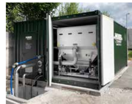
Kontejnerový systém jako trvalá instalace v mlékárenském průmyslu, průtok cca 35 m 3 /h.
