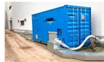
Pronájem zařízení k předčištění odpadních vod v mlékárenském průmyslu, výkon přibližně 15 m 3 /h.
