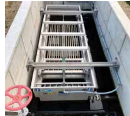
Výměník tepla HUBER RoWin C instalovaný v betonovém žlabu.
