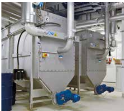
Výměník tepla HUBER RoWin pro rekuperaci energie.
